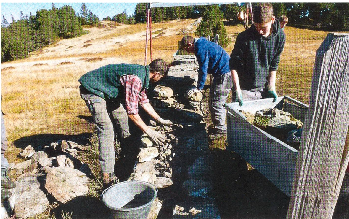
Abbildung 14: Instandstellung einer Trockenmauer. (Foto: Ruedi Wyss)
