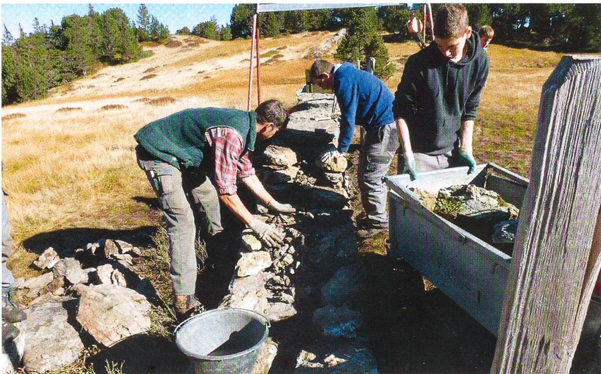
Abbildung 14: Instandstellung einer Trockenmauer. (Foto: Ruedi Wyss)
