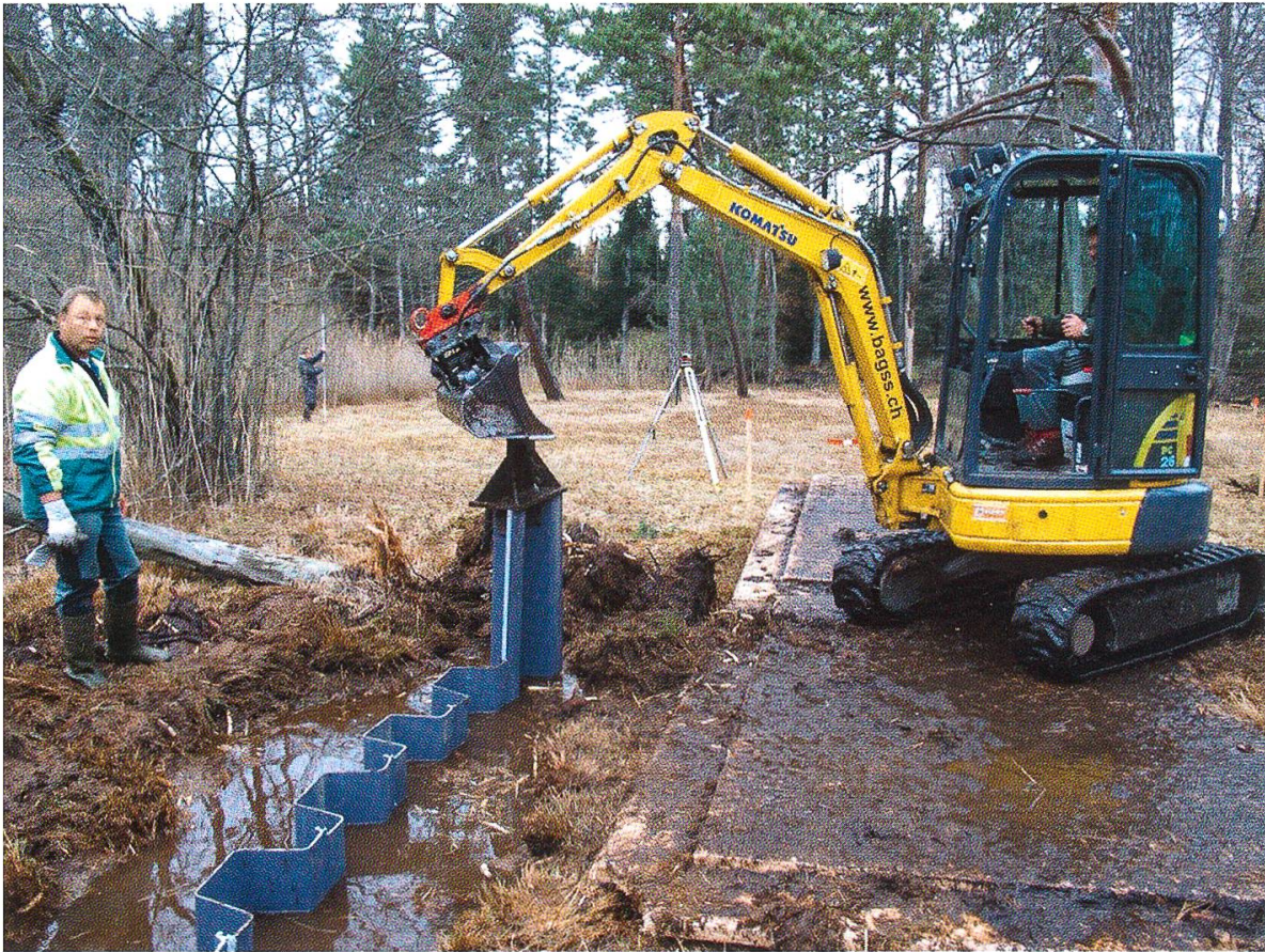
Abbildung 10: Einbau des Oberflächendamms im Moorzentrum. (Foto: Thomas Leu)
