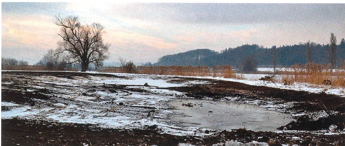
Abbildung 11: Die Abteilung Naturförderung hat in Seeufnähe neue Flachgewässer gebaut und den Boden ausgemagert. Nährstoffreicher Oberboden wurde auf die benachbarte Fläche verschoben. Dies bedeutet für die Landwirtschaft sowie für die renaturierte Fläche eine Bodenverbesserung. (Foto: Petra Graf)
