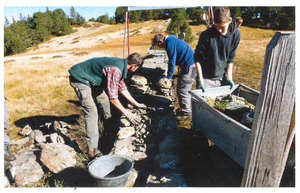
Abbildung 14: Instandstellung einer Trockenmauer. (Foto: Ruedi Wyss)
