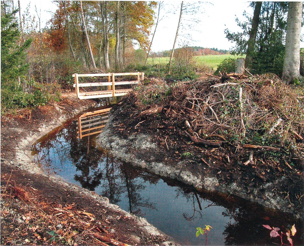
Abbildung 9: Grabenrinne mit neuem Übergang am Südrand des Moores. (Foto: Thomas Leu)
