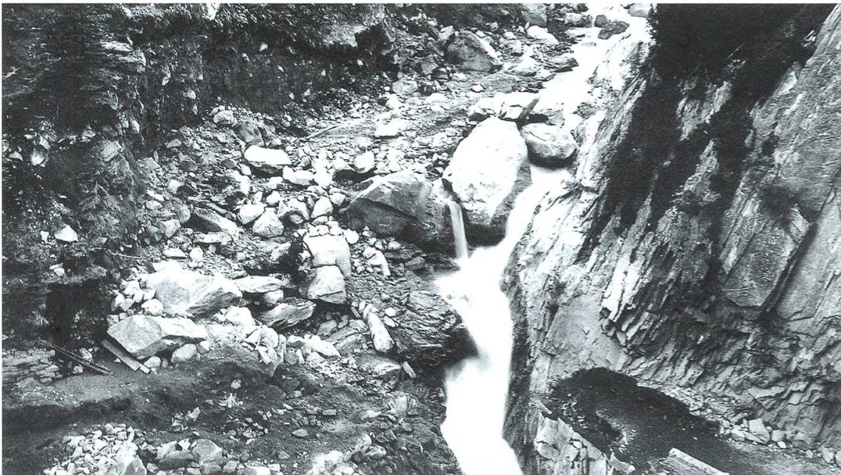
Abbildung 3: Zerstörte Grimselstrasse bei der Aerenbachbrücke nach dem Ausbruch vom 3. Oktober 1921.
