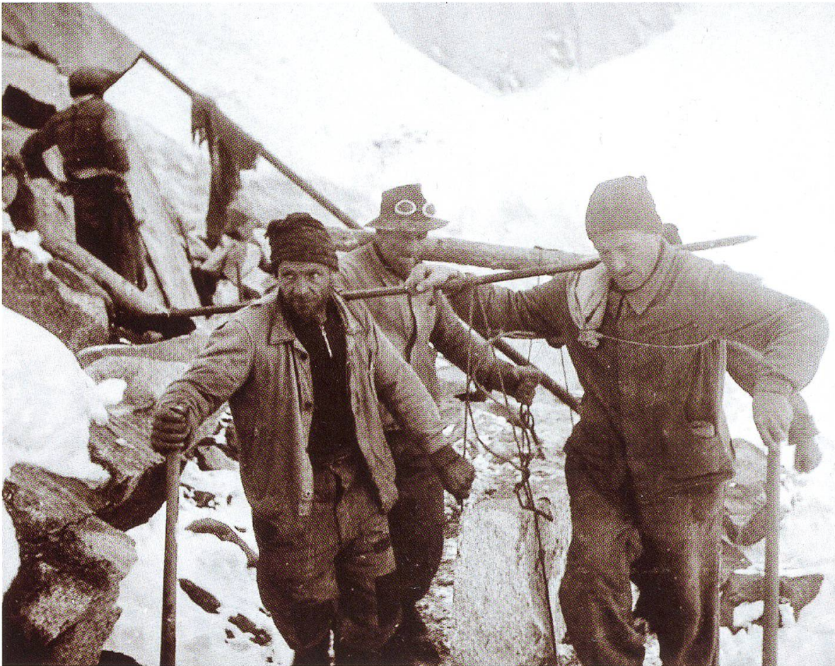
Abbildung 18: Steinträger beim Bau des Hangkanals am 28. Oktober 1944.
