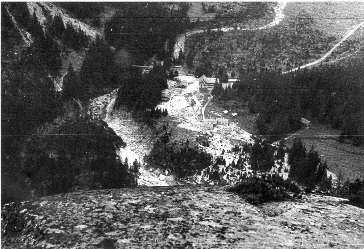
Abbildung 6: Blick flussaufwärts in Richtung Hotel Handegg am 16. Oktober 1942.
