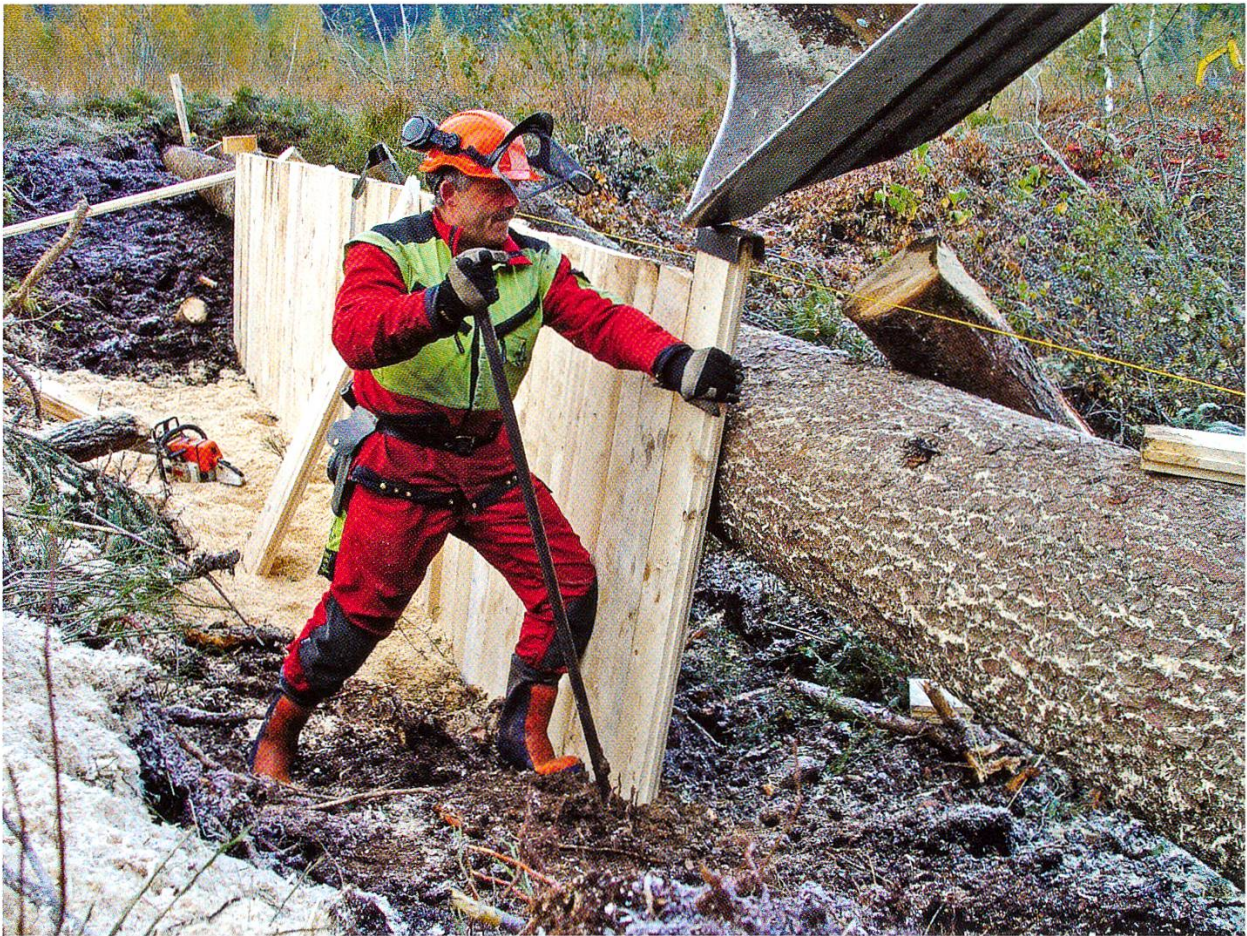
Abbildung 17: Verankerung der Holzsperrn im Boden. (Foto: Erwin Jörg)
