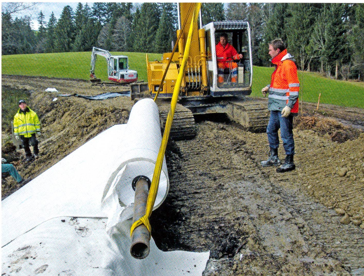
Abbildung 16: Abdichtung eines Dammes mit einer Bentonitmatte. (Foto: Ruedi Keller)
