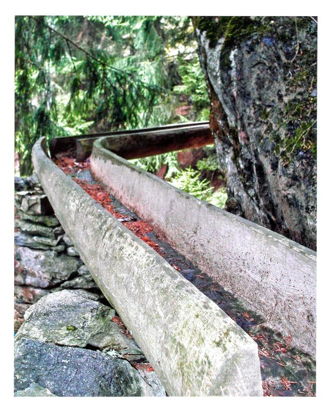
ruhten. Um auf der ganzen Strecke ein möglichst geringes Gefälle beizubehalten, führten die Wasserfuhren nicht selten durch senkrechte Felswände. Hier war der Bau besonders anspruchsvoll: Zuerst wurden Löcher in die Felsen gehauen, in denen mit einer faszinierenden Technik Tragbalken fixiert wurden. Auf diesen befestigte man schliesslich die Holzkännel, in denen das vom feinen Sand milchig trüb gefärbte Gletscherwasser floss.
