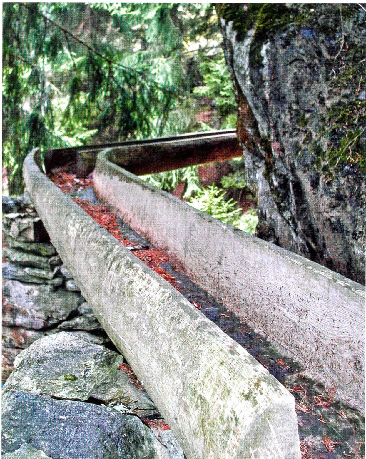
ruhten. Um auf der ganzen Strecke ein möglichst geringes Gefälle beizubehalten, führten die Wasserfuhren nicht selten durch senkrechte Felswände. Hier war der Bau besonders anspruchsvoll: Zuerst wurden Löcher in die Felsen gehauen, in denen mit einer faszinierenden Technik Tragbalken fixiert wurden. Auf diesen befestigte man schliesslich die Holzkännel, in denen das vom feinen Sand milchig trüb gefärbte Gletscherwasser floss.
