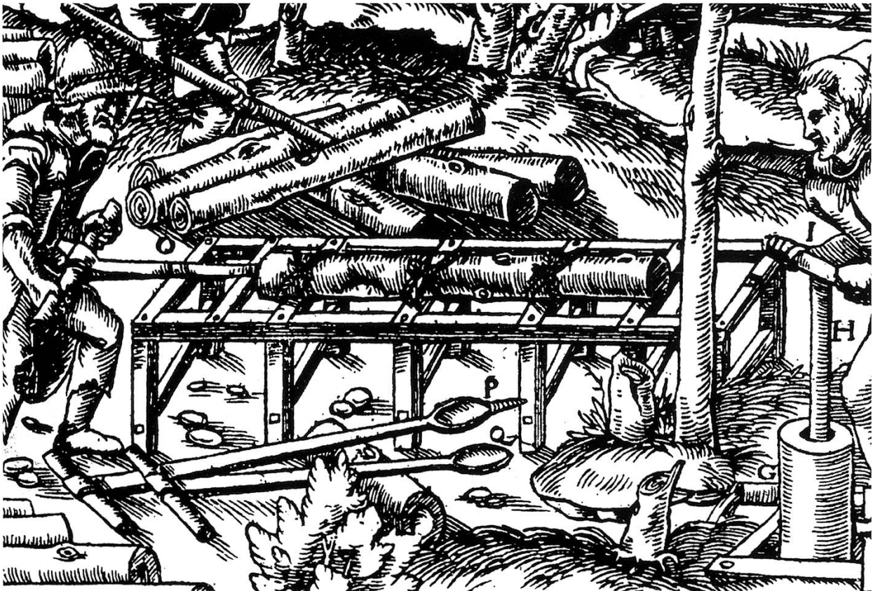
Abbildung 6: Darstellung des Teuchelbohrens. Holzschnitt aus Georg Agricola 1556 (BAERISWY/GERBER, Ratsherren, 57) 6 .
