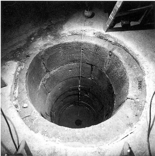
Abbildung 2: Ein Beispiel für einen privaten Sodbrunnen aus Sandsteinquadern. 13. Jahrhundert, Bern Junkerngasse 1 (GUTSCHER/SUTER, Archäologie im Kanton Bern 1, 63 f.) 12 .
