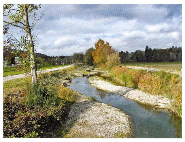
Aufgeweitete und renaturierte Gürbe mit Niederwasserrinne und abgeflachten, variierenden Böschungsneigungen. Blick in Fliessrichtung. (Bild M. Zahno)
