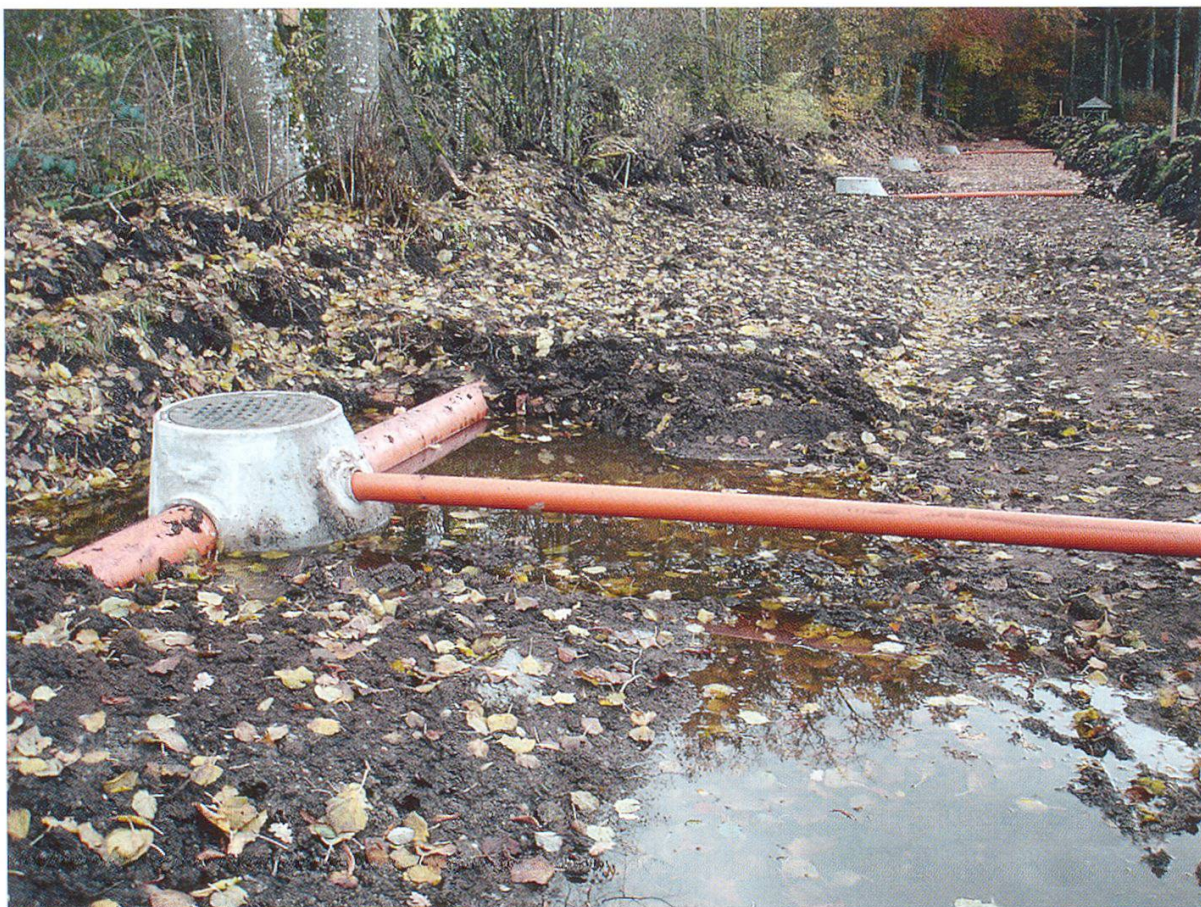
Abbildung 9: Geschlossene Hauptleitung mit von rechts einmündenden Drainagerohren während des Baus. (Foto: Thomas Leu)
