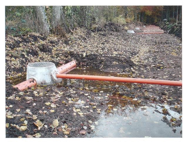
Abbildung 9: Geschlossene Hauptleitung mit von rechts einmündenden Drainagerohren während des Baus. (Foto: Thomas Leu)
