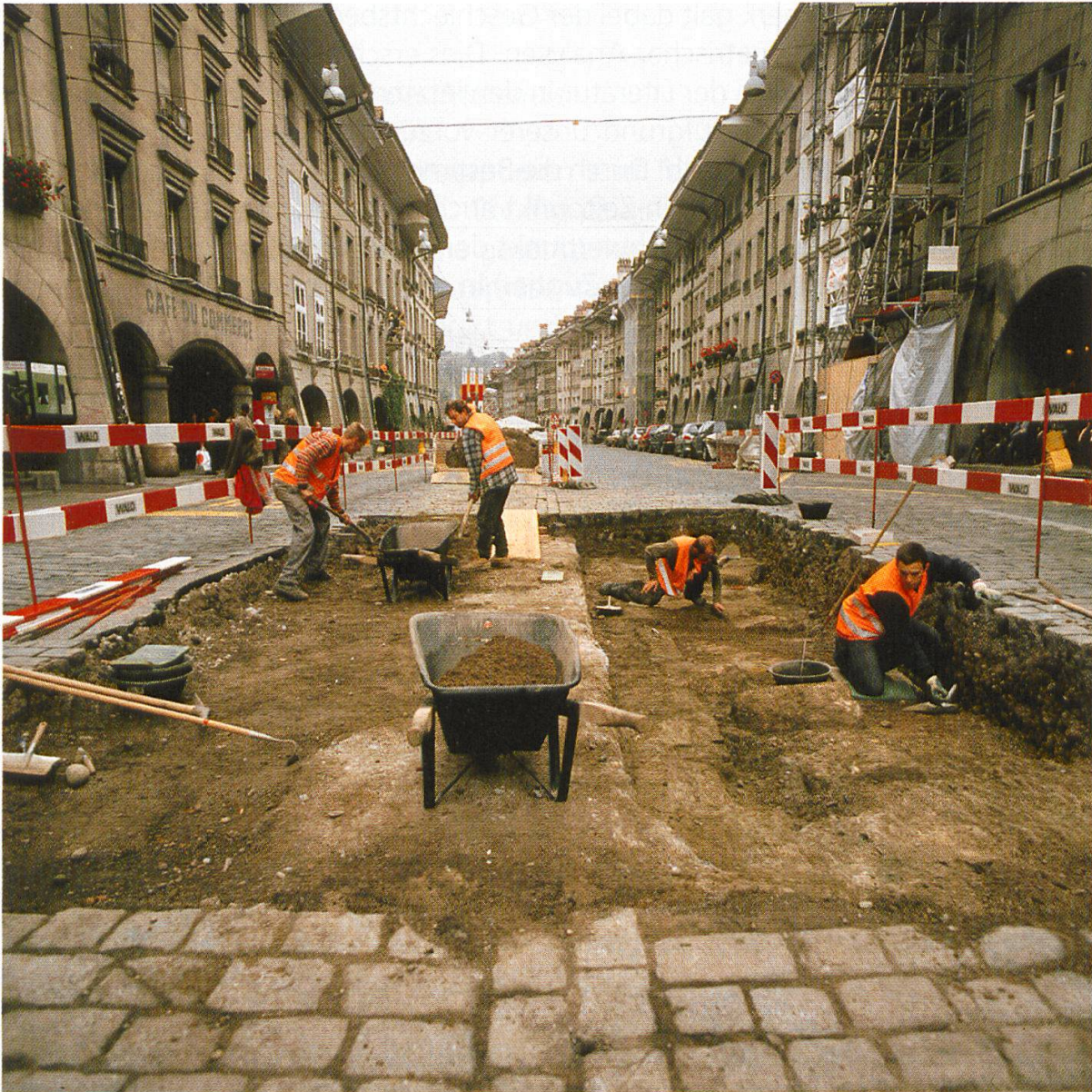
Abbildung 1: Archäologische Grabungsarbeiten 2004 in der Kramgasse. Nach dem Entfernen des modernen Strassenpflasters werden die älteren Schichten und Mauern sorgfältig hervorpräpariert. In der Bildmitte ist die Ende des 19. Jahrhunderts entstandene Abdeckung des Stadtbachs zu sehen.
