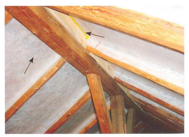
Figure 23: Doublure du lambrissage au moyen d'une bâche et obstruction des fentes des planches. (Photo: BIF/Ch. Brossard)
