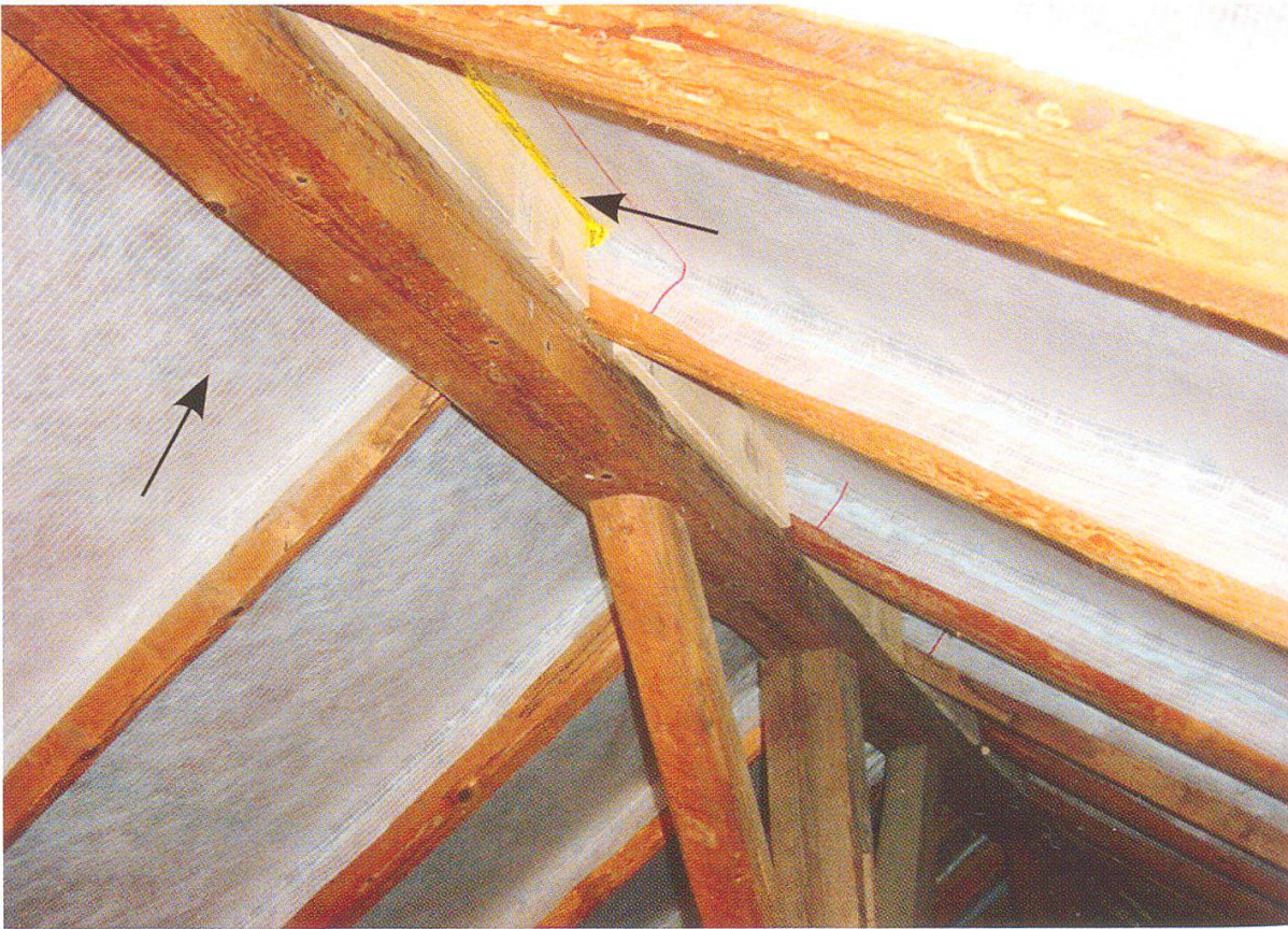
Figure 23: Doublure du lambrissage au moyen d'une bâche et obstruction des fentes des planches. (Photo: BIF/Ch. Bossard)
