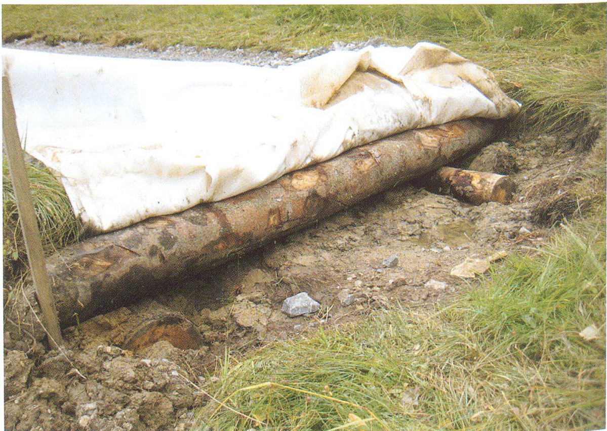
Abbildung 7: Unterbau mit Holzprügellage und Vlies für den Bewirtschaftungsweg im Naturschutzgebiet Unterer Stauffen, Habkern. (Foto: NSI, Aug. 2008)
