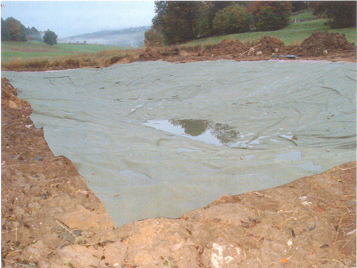
Abbildung 2: Damit der Tümpel auf sehr durchlässigem Untergrund das Wasser behält, musste er mit einer Folie abgedichtet werden. (Foto: NSI, 2008)
