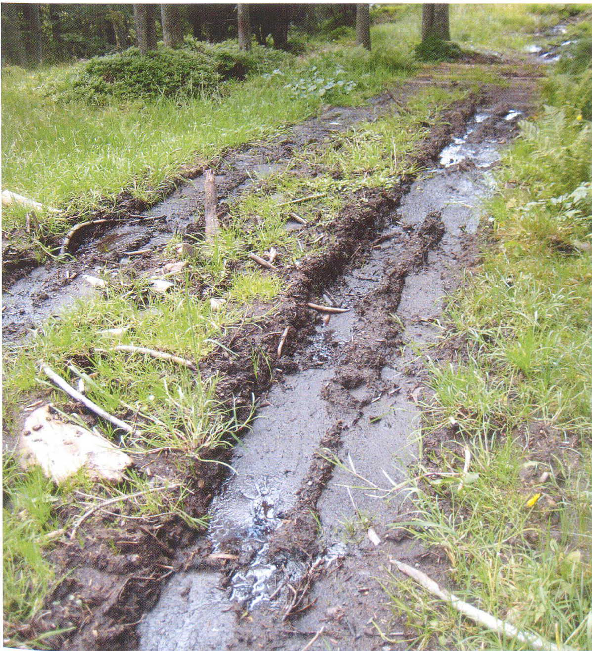
Abbildung 8: Schäden durch Fahrspuren, welche mit dem Bewirtschaftungsweg verschwinden. (Foto: NSI, Aug. 2008)
