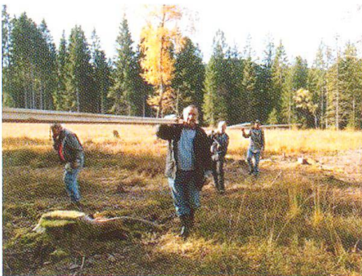
Abbildung 6: Die Helfer beim Sperrenbau im NSG Wissenbach Ost. (Foto: E. Albrecht, STB, Okt. 2008)
