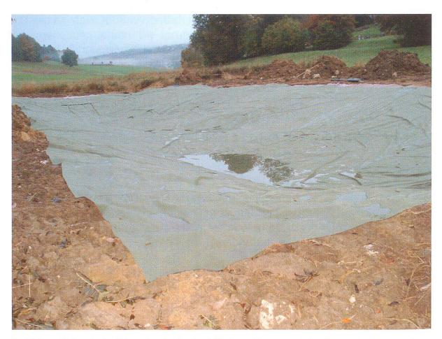
Abbildung 2: Damit der Tümpel auf sehr durchlässigem Untergrund das Wasser behält, musste er mit einer Folie abgedichtet werden. (Foto: NSI, 2008)
