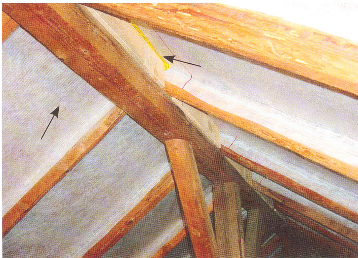
Figure 23: Doublure du lambrissage au moyen d'une bâche et obstruction des fentes des planches. (Photo: BIF/Ch. Brosard)
