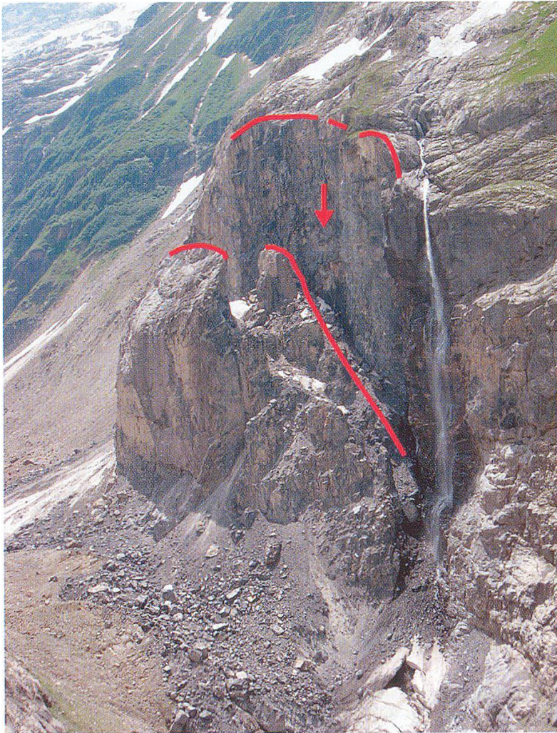
Abbildung 4: Neben dem zum Unteren Grindelwaldgletscher stürzenden Bach der Schlosslouwina in der Ostflanke der Eiger-Hörnli hat sich eine rund 200 m hohe und 250 m breite Felspartie vom Berg gelöst, in zwei Pakete aufgeteilt und um insgesamt rund 50 m gesenkt. Aufnahme vom 24. Juni 2008. Die Spalte war im Juni 2006 von Hansruedi Burgener, Wirt auf der Bäregg, entdeckt worden. Die Vorgänge wurden in der Folge vom Grindelwaldner Rettungschef Kurt Amacher und vom Geologen Hansrudolf Keusen genau verfolgt. Man rechnete zuerst mit einem nahe bevorstehenden grossen Sturz der auf rund 2 Millionen m 3 geschätzten Felsmasse. Es stürzte jedoch im Juli 2006 nur etwa ein Fünftel davon auf den Gletscher. Der Hauptteil löste sich zwar zunehmend vom Hang und teilte sich in zwei Pakete auf, stürzte aber nicht, sondern sank mit seinem Fuss langsam immer tiefer
