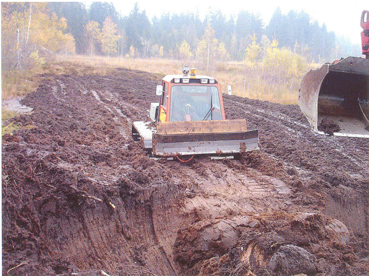
Abbildung 7: Zusammenschieben des Torfes mit einer umgebauten kleinen Pistenmaschine. (Foto: Naturschutzinspektorat, November 2007)
