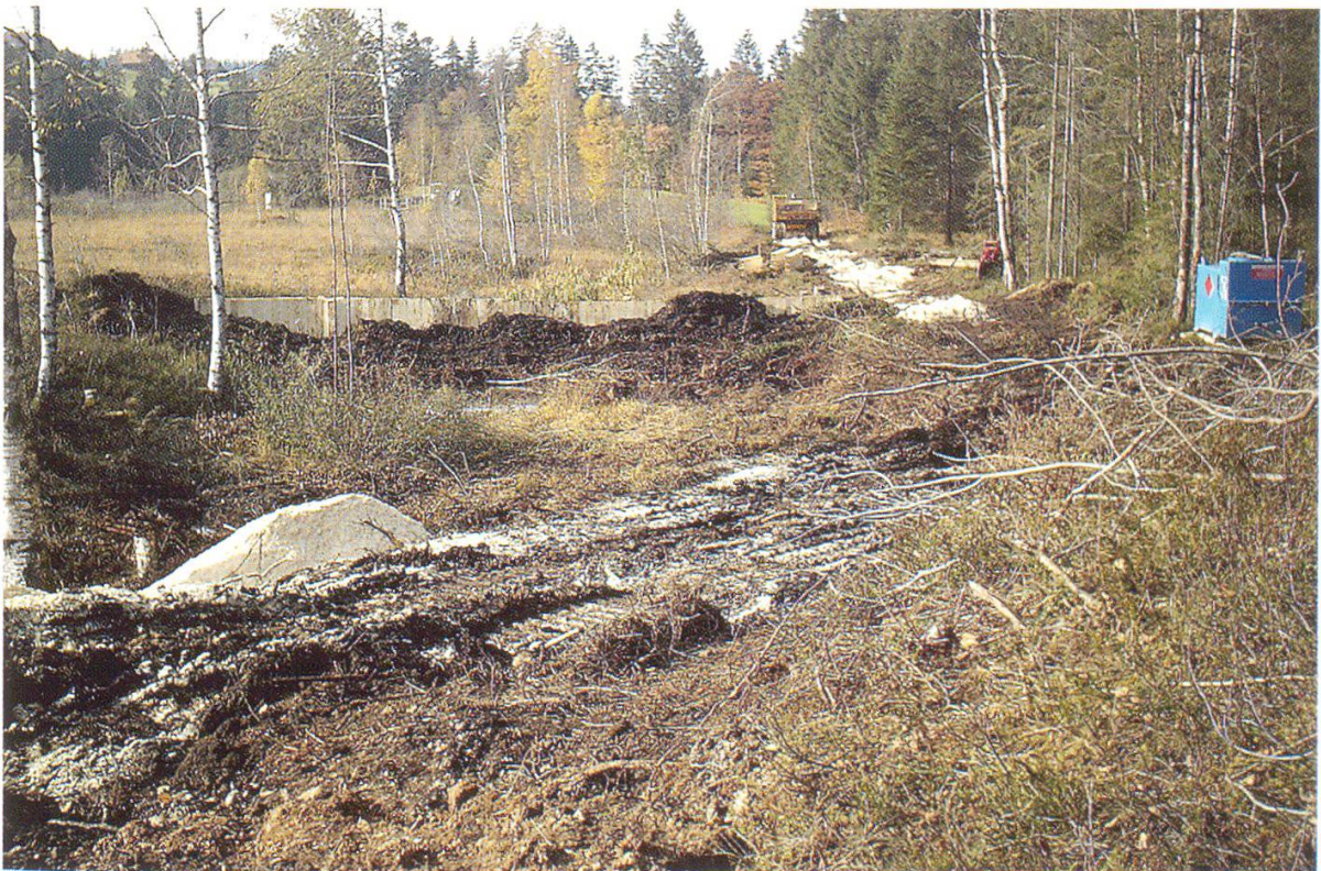
Abbildung 9: Die Moorregenerierung bedingt eine «Grossbaustelle», damit der Hauptgraben auf einer Gesamtlänge von 211 m fachtechnisch aufgefüllt werden kann! (Foto: Naturschutzinspektorat, November 2007)
