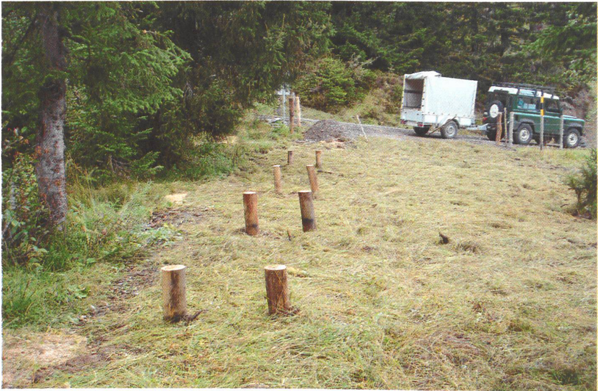
Abbildung 12: Nach Rückbau des Bewirtschaftungsweges wird ein Moorsteg zusammen mit den Grundeigentümern errichtet. (Foto: R. Wyss, Oktober 2006)
