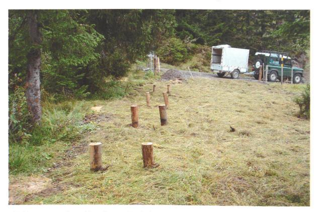
Abbildung 12: Nach Rückbau des Bewirtschaftungsweges wird ein Moorsteg zusammen mit den Grundeigentümern errichtet. (Foto: R. Wyss, Oktober 2006)
