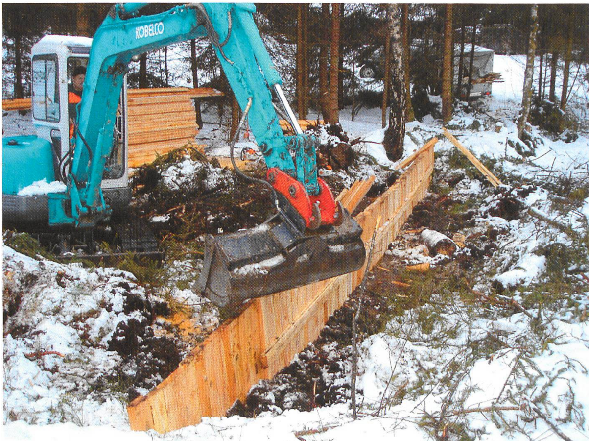
Abbildung 5: Doppelwandiger Sperrenbau Siehenmoos. (Foto: Naturschutzinspektorat, Dezember 2005)
