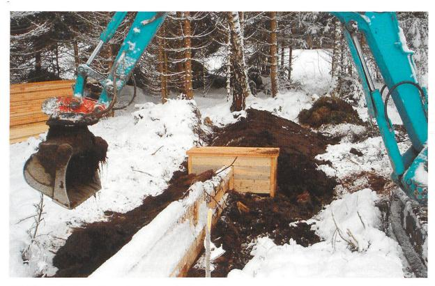
Abbildung 6: Kontrollschacht für regulierbaren Wasserstand. (Foto: Naturschutzinspektorat, Dezember 2005)
