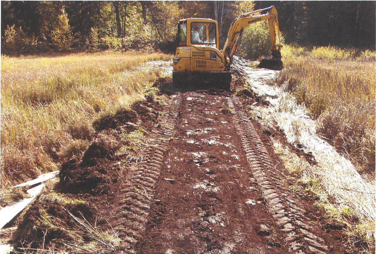
Abbildung 8: Petite rétro-pelleteuse sur chenille en action sur une digue de la réserve naturelle des Pontins à St-Imier. (Photo: S. Guerne, septembre 2004)
