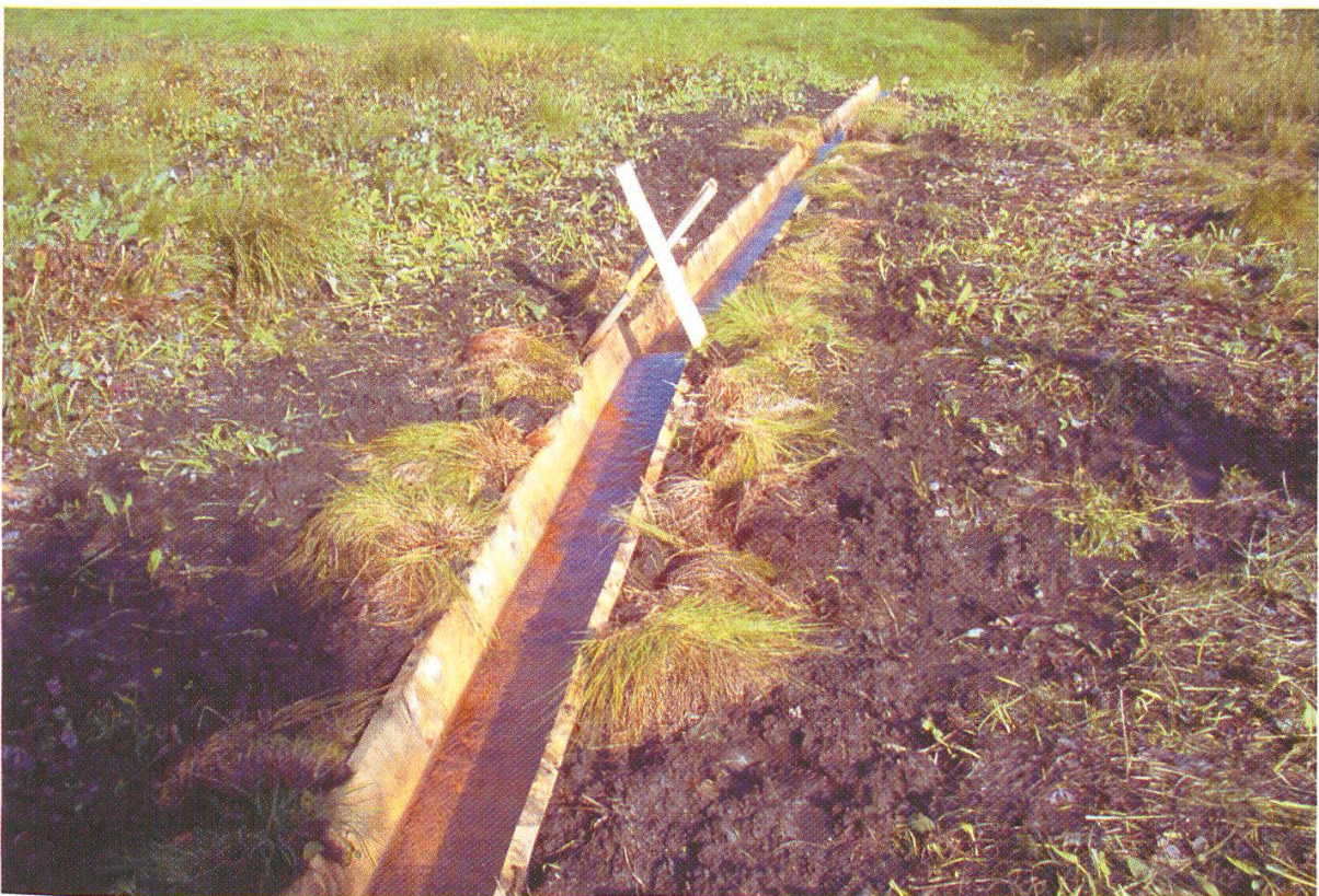
Abbildung 7: Canalisation d'une voie d'eau pour éviter l'érosion du haut-marais de la Chaux d'Abel. (Photo: S. Guerne, octobre 2005)
