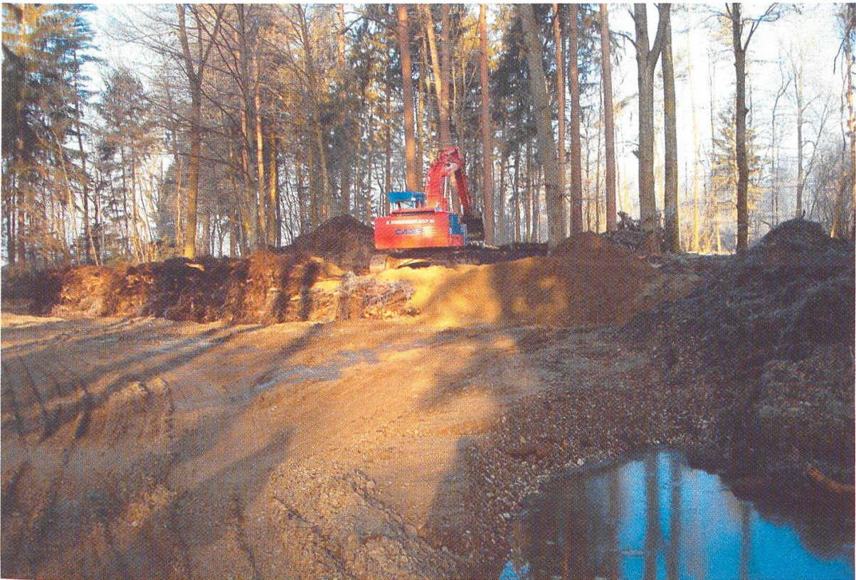
Abbildung 9: Grande rétro-pelleteuse en action pour renaturaliser l'ancien bras de l'Aare à Belp. (Photo: S. Guerne, décembre 2004)
