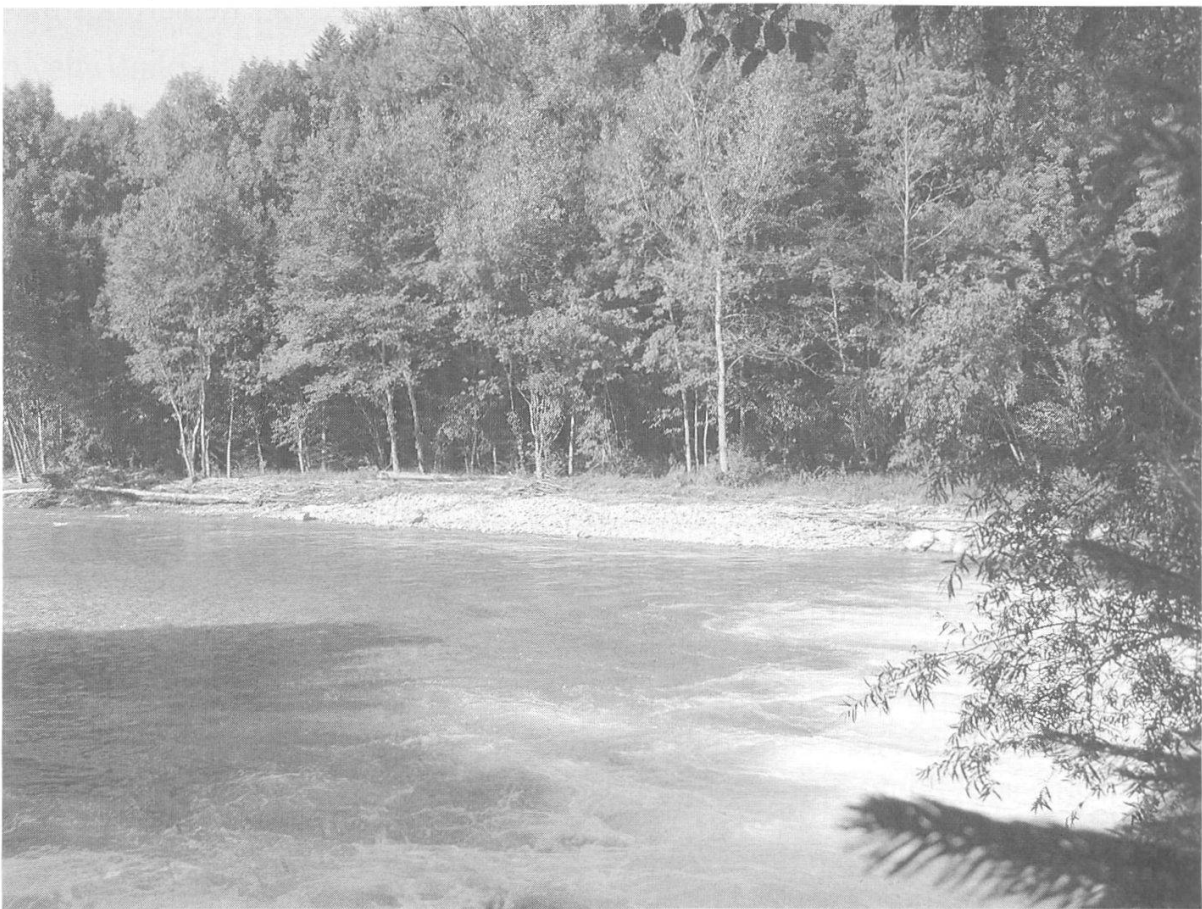
Abbildung 22: Sicht auf das Renaturierungsprojekt am rechten Ufer, acht Monate nach dem Spatenstich. (Foto: B. Käufeler, Impuls, Thun, August 2002)
