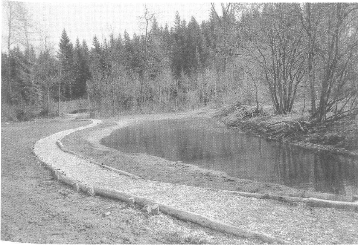
Abbildung 8: Neu erstellter Flachteich als Absetzbecken. (Foto W. Frey, April 2002)
