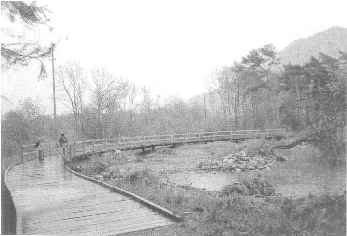
Abbildung 7: Neuer Holzsteg um die Trichtermündung. (Foto W. Frey, April 2002)
