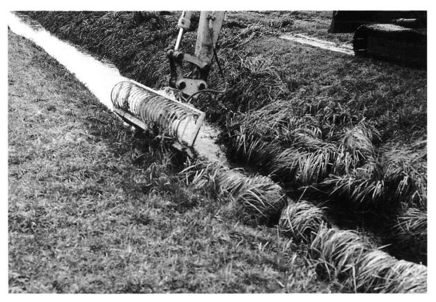
Abbildung 22: Maschinelle Räumung eines Wiesenbächleins mit dem schonenden Mähkorb. (Foto M. Graf, Februar 2000)
