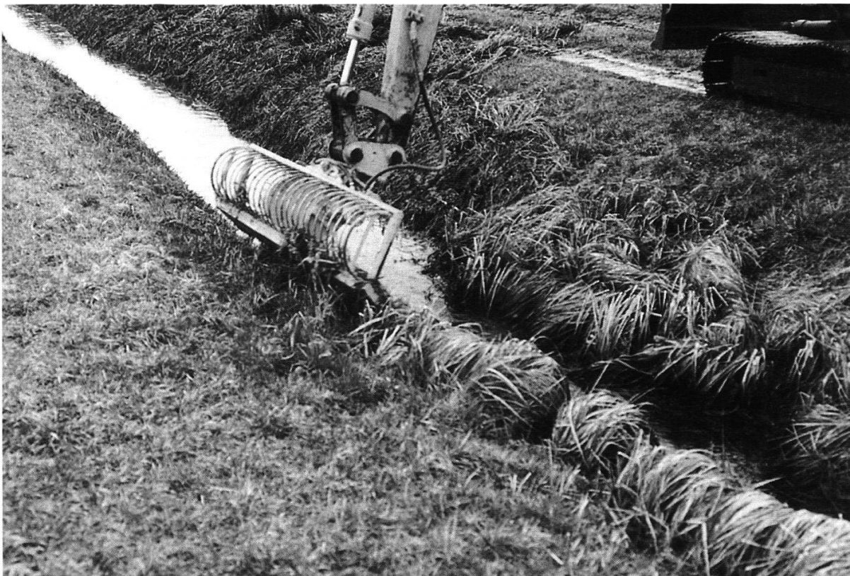
Abbildung 22: Maschinelle Räumung eines Wiesenbächleins mit dem schonenden Mähkorb. (Foto M. Graf, Februar 2000)
