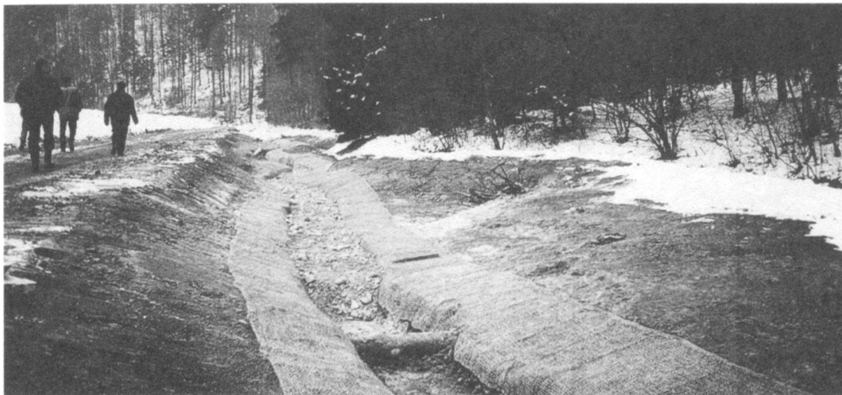
Abbildung 8: Das neue Bachbett konnte grösstenteils trocken gebaut werden. Infolge des geringen Längsgefälles konnte auf Uferverbauungen verzichtet werden. Zur Stabilisierung der Sohle wurden in grösseren Abständen Querhölzer sohlenbündig eingebaut. (Foto P. Augustin, Februar 1998)
