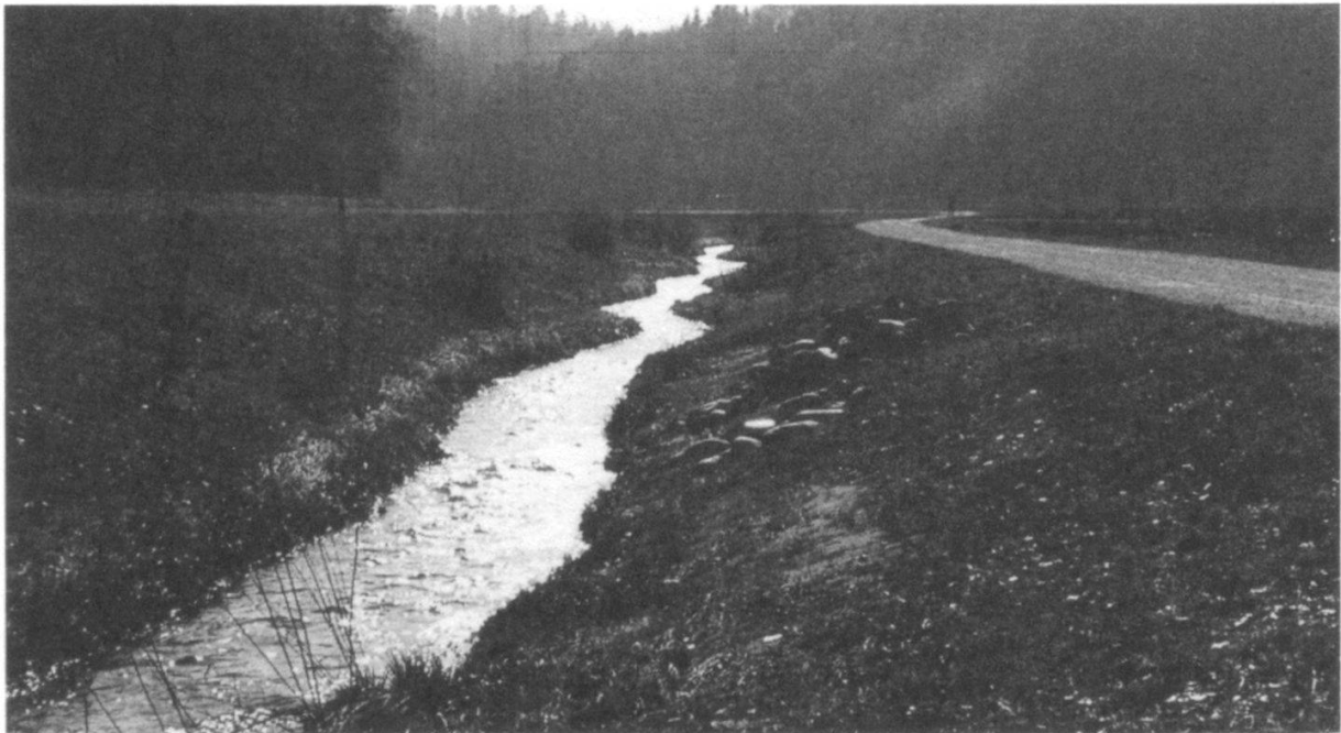
Abbildung 7: Das neu gestaltete Bachbett: Unterschiedliche Sohlenbreiten und eine abwechslungsreiche Linienführung bewirken vielfältige Strömungsverhältnisse. An den Böschungen wurden Gehölzgruppen und Kleinstrukturen angelegt. Mit der Zeit wird sich der Bach zu einem wertvollen Vernetzungselement entwickeln. (Foto P. Augustin, März 1999)
