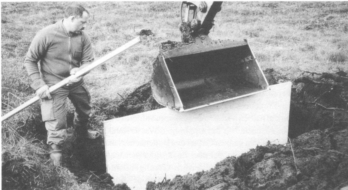
Abbildung 3: Errichten einer Sperre mit Holzbrett 2,5 x 1,5 m. Beidseitige Schüttung von Torf und leichter Überhöhung. (Foto R. Keller, Mai 1998)
