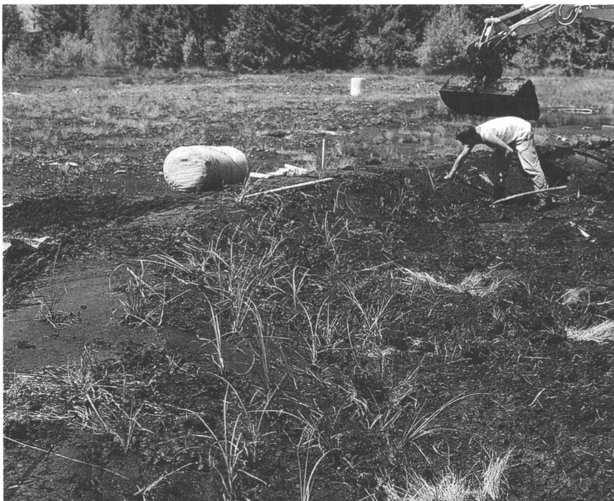
Abbildung 6: Befestigen der Sonnenseite der Dammböschung mit verpflanztem schmalblättrigem Wollgras ( Eriophorum angustifolium ). (Foto NATURA, 1997)
