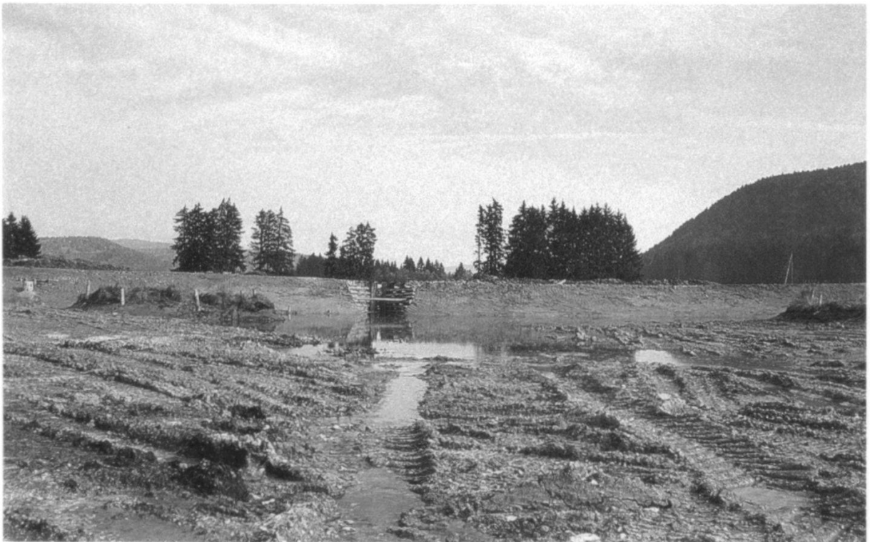
Figure 10: Début du remplissage de l'étang (Photo Fr. Gfeller, 14.10.1995).
