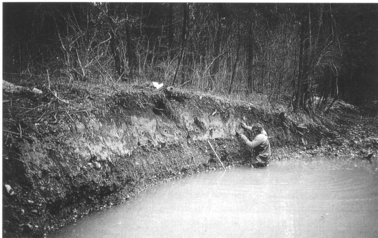
Abbildung 16: Detail einer Uferpartie an einem frisch ausgehobenen Stillwasser. Es ist ein Steilufer entstanden, in welches gerade einige Tonröhren eingelegt werden (Foto A. Gmür und M. Brügger, März 1996).
