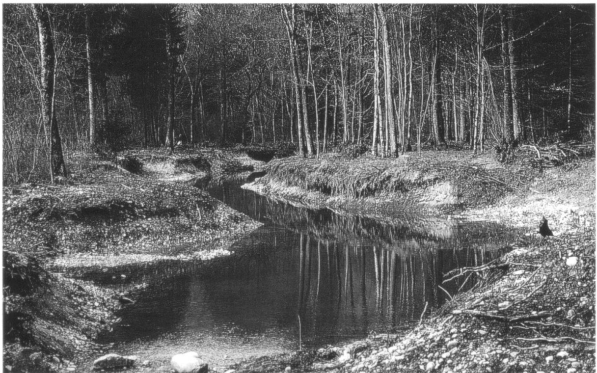
Abbildung 15: Fertiggestellter Seitenarm der Hauptgiesse. Dieser Seitenarm dient zugleich der Zufuhr von Aareinfiltraten aus den Infiltrationsgräben in die Hauptgiesse (Foto A. Gmür und M. Brügger, März 1996).
