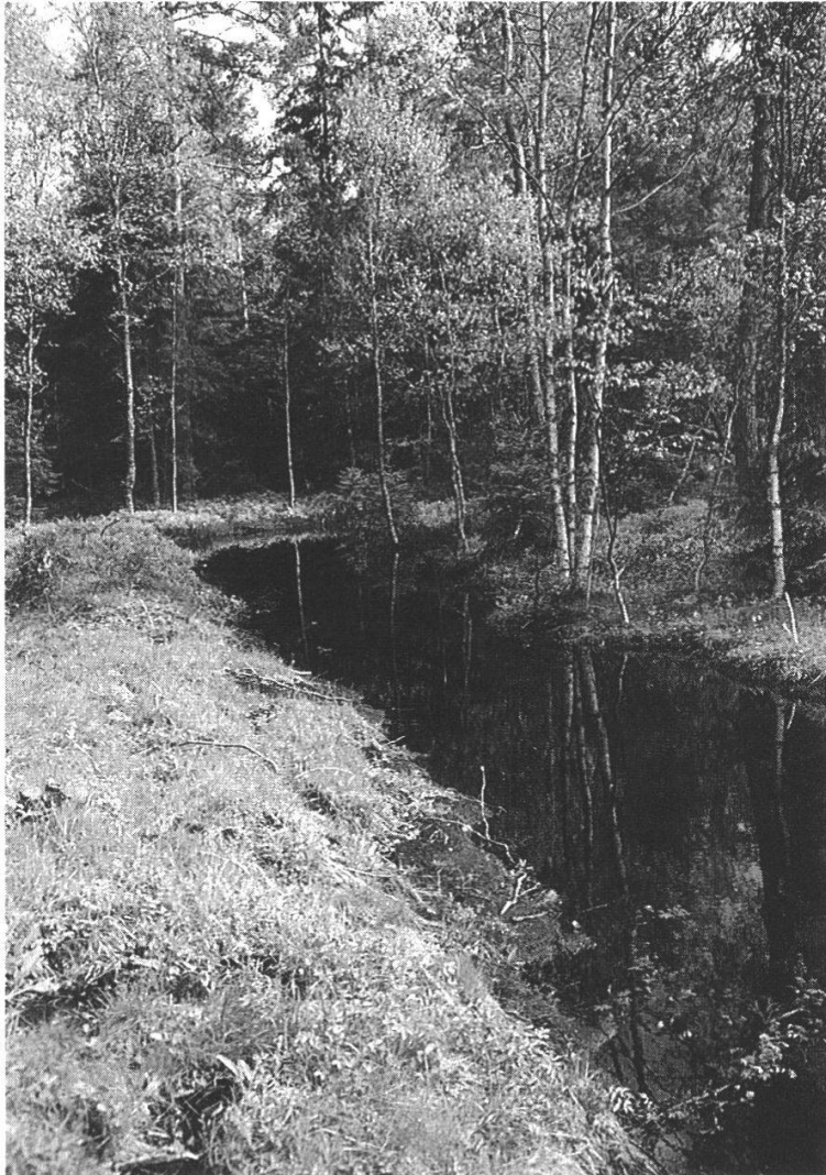
Figure 6: La digue est rhabillée par des mottes de tourbe. A l'arrière les eaux retenues forment un vaste plan d'eau.
