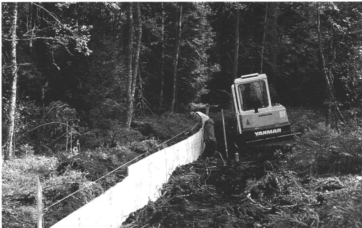
Figure 5: La digue est construite au moyen de panneaux de bois.
