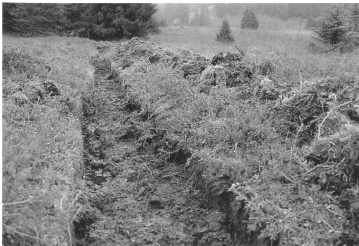
Abbildung 11: Die Massnahme: Gräben ausheben bis auf den gewachsenen Torf, bevor mit dem Auffüllen begonnen werden kann.
