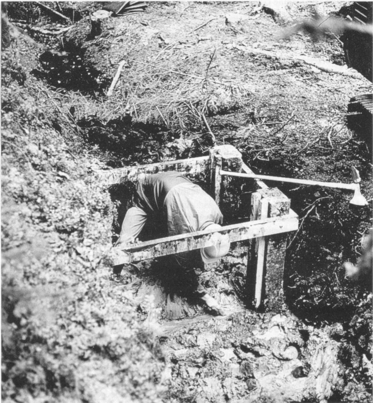
Figure 3: Construction du système de régulation: mise en place du noyau de marne. (Photo Ph. Grosvernier)
