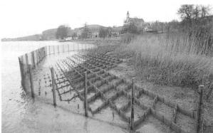
Abbildung 3: Sedimentationskassetten bei Obermaurach im Landkreis Bodenseekreis (links: Luftbildübersicht, rechts: Details).\*
