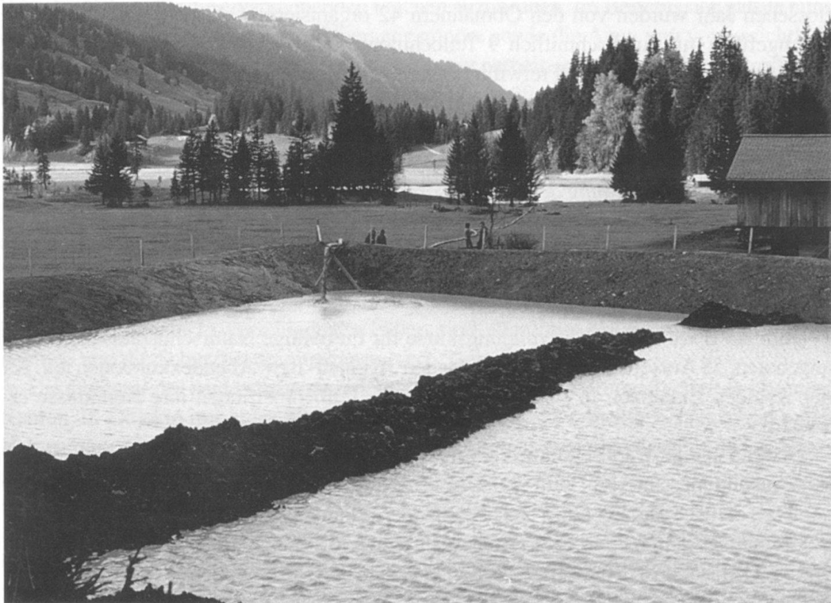
Abbildung 4: Das Absetzbecken zu Beginn der Saugbaggerarbeiten, Blick nach Nordwesten, im Hintergrund der Lauenensee. (Foto Bfö, Anfang Oktober 1990)
