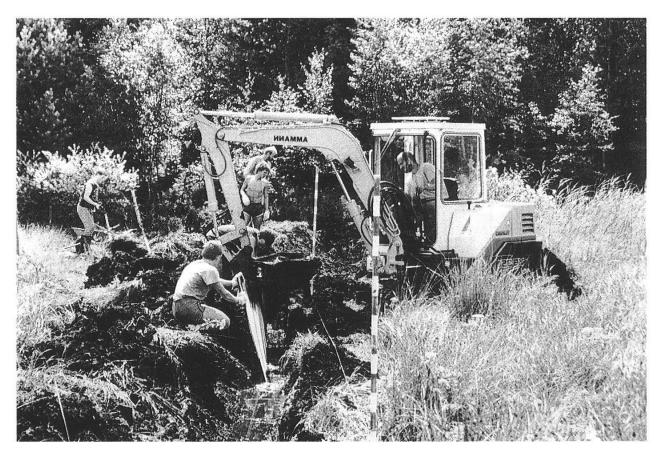
Abbildung 2: Einbau der Holzplatten für die Dämme in Les Pontins mit Moorraupe und Handbeihilfe durch Lehrlinge. (Foto H. Garo, 2. August 1988)
