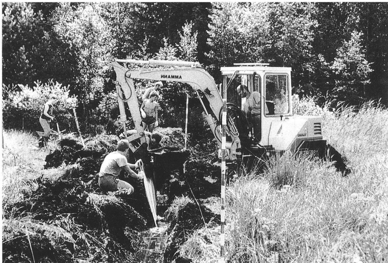
Abbildung 2: Einbau der Holzplatten für die Dämme in Les Pontins mit Moorraupe und Handbeihilfe durch Lehrlinge. (Foto H. Garo, 2. August 1988)
