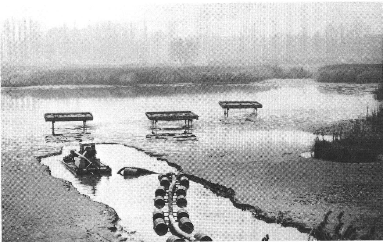
Abbildung 4: Ausbaggerung der Lagune mit einem Saugbagger. In der Bildmitte sind die drei Flussee-schwalbenflösse und im Vordergrund die schwimmende Transportleitung zu erkennen. (Aufnahme A. Bossert, 28. November 1986)
