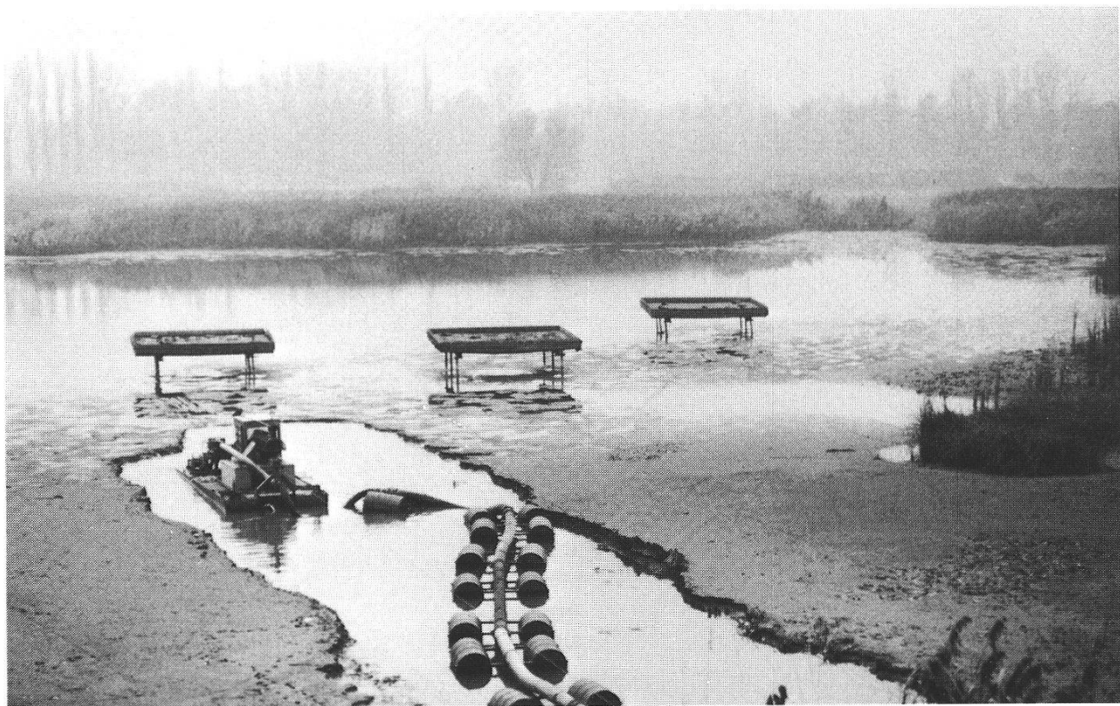
Abbildung 4: Ausbaggerung der Lagune mit einem Saugbagger. In der Bildmitte sind die drei Flussseeswalbenflösse und im Vordergrund die schwimmende Transportleitung zu erkennen. (Aufnahme A. Bossert, 28. November 1986)
