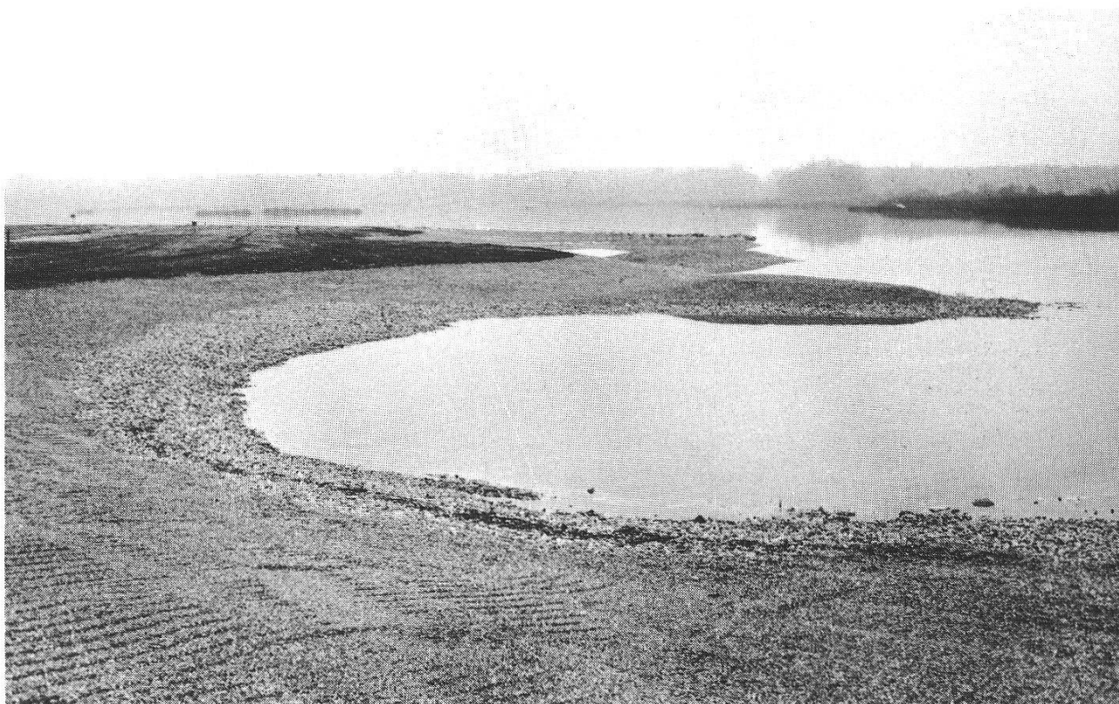
Abbildung 5: Die Berner Insel am Fanel unmittelbar nach der Sanierung. Das bis 8 m aberodierte landseitige Ufer wurde als sehr flacher Bereich wiederhergestellt. Gleichzeitig vergrössern Buchten und Buhnen die Uferlinie. Wasserstand 429.02. (Mittlerer Sommerwasserstand: 429.50). (Aufnahme A. Bossert, 10. November 1987)
