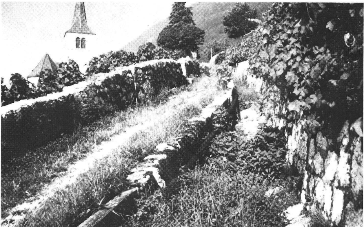
Abbildung 12: LK 1145 Bielersee: Elemente der traditionellen Reblandschaft sind in Ligerz noch zahlreich erhalten (im Bild: Weg und Wassergraben in Doppelfunktion).
