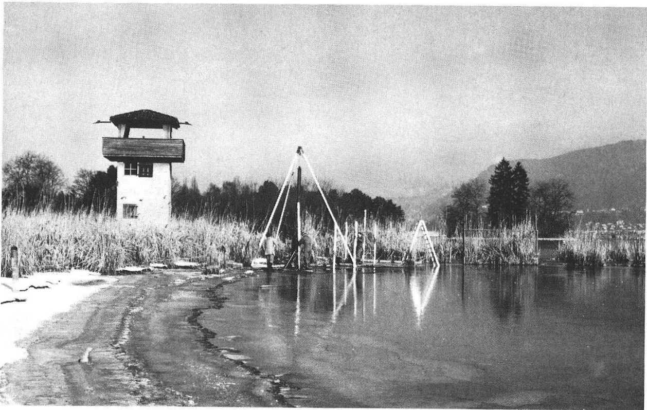
Abbildung 8: Umzäunungsarbeiten im Naturschutzgebiet Gwattlischenmoos im Januar 1979. Die 4,5 Meter langen Pfähle wurden mit Hilfe eines «Dreibeines» eingerammt. Links davon der Beobachtungsturm. (Foto: B. Stüssi, 18. Januar 1979.)
