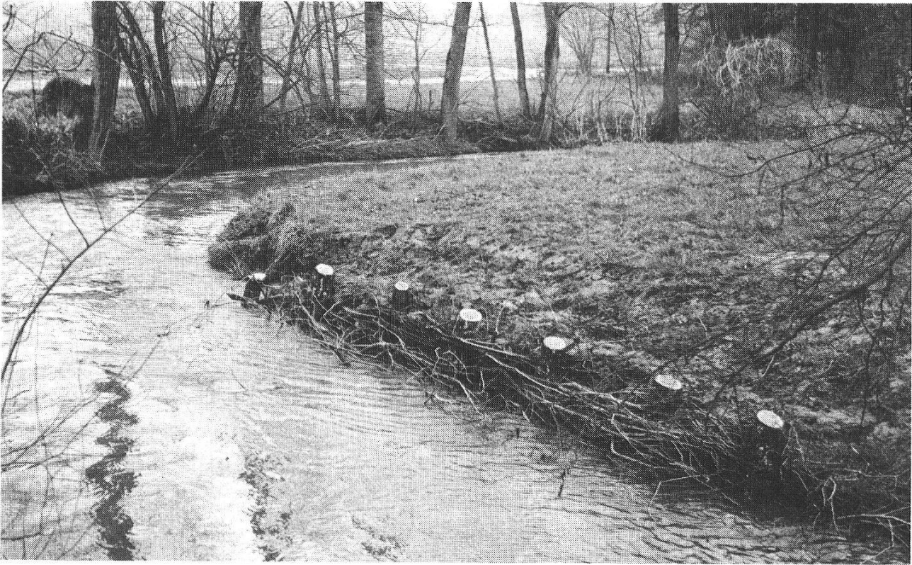
Abbildung 6: Beispiel 2: Flussabwärts aufgenommen: Eichenpfähle mit Astwerk verflochten, dahinter mit Kies gefüllte Geotextilsäcke, Grasnarbe darüber abgekanet. (Foto M. Cloetta)
