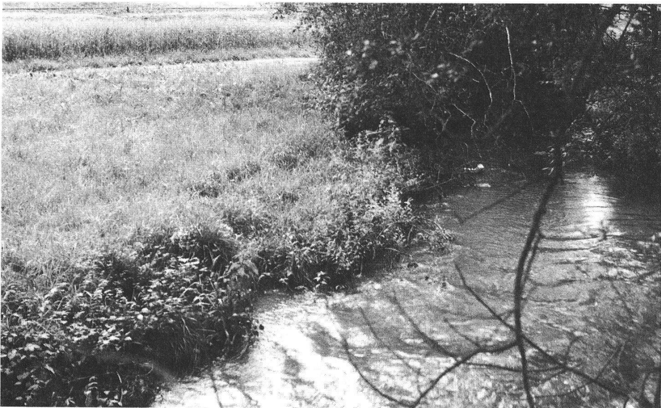
Abbildung 7: Beispiel 2: Flussaufwärts aufgenommen, 3 Monate später, mit Hilfe des technischen Auswaschungsschutzes kann sich die Graskante wieder stabilisieren. (Foto H. Zeh)
