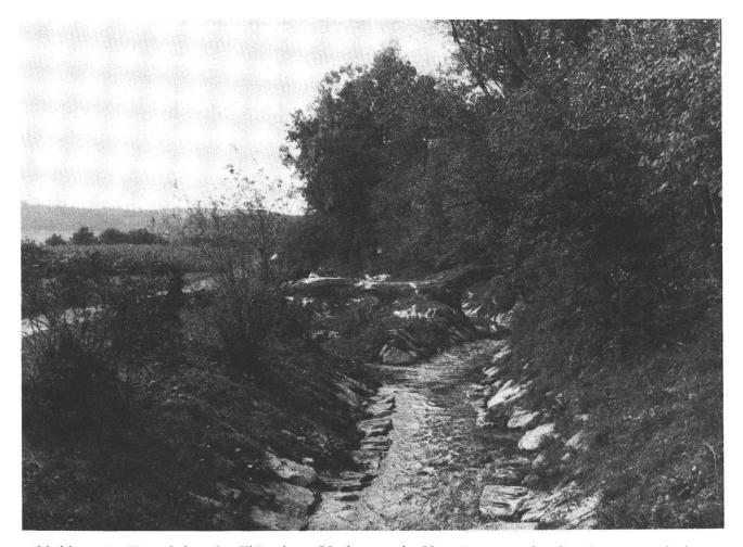
Abbildung 1 Korrektion des Flüsschens Uerke zwecks Vergrösserung des Gewässerquerschnittes.
