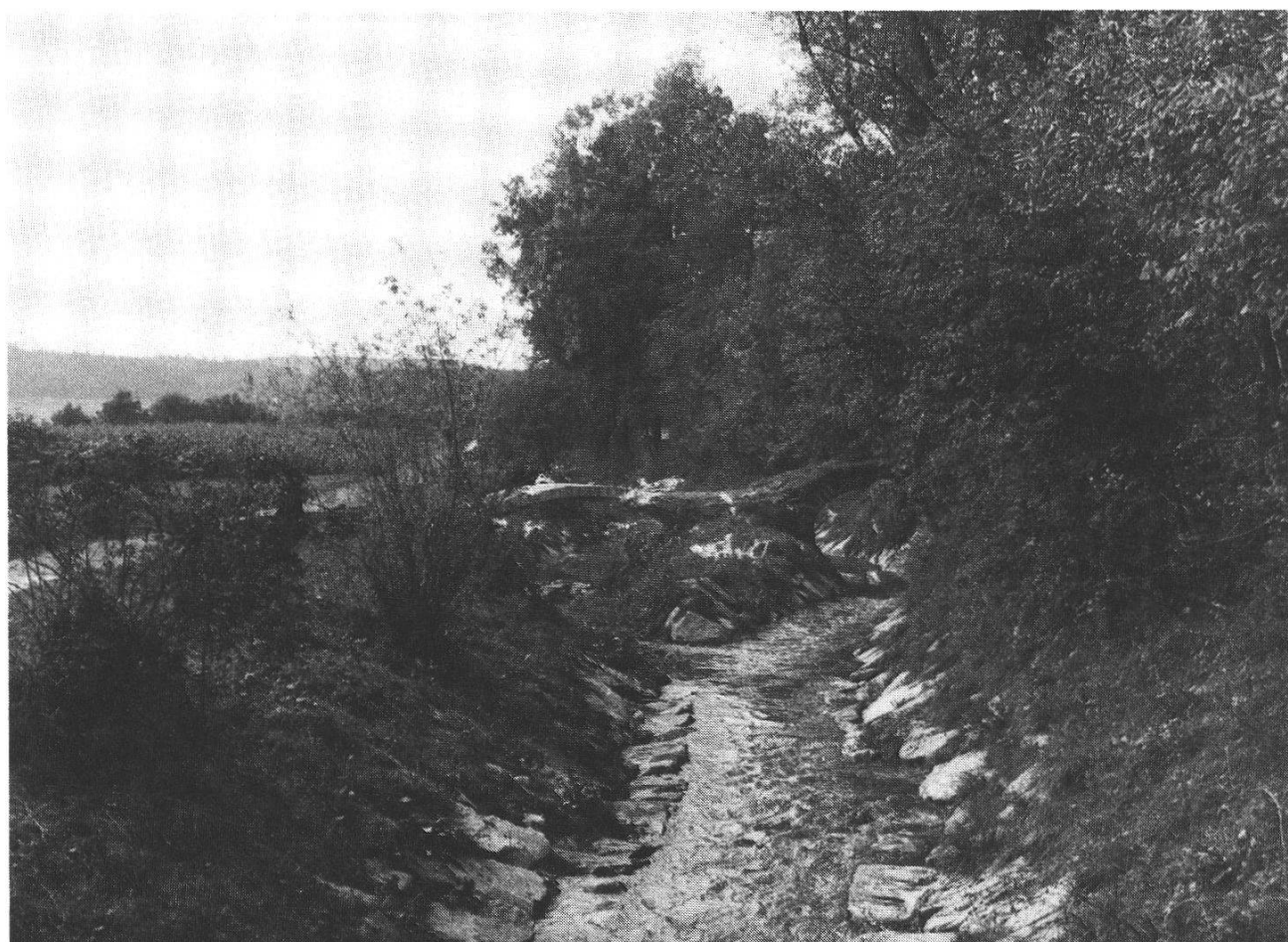
Abbildung 1 Korrektur des Flüsschens Uerke zwecks Vergrösserung des Gewässerquerschnittes.
