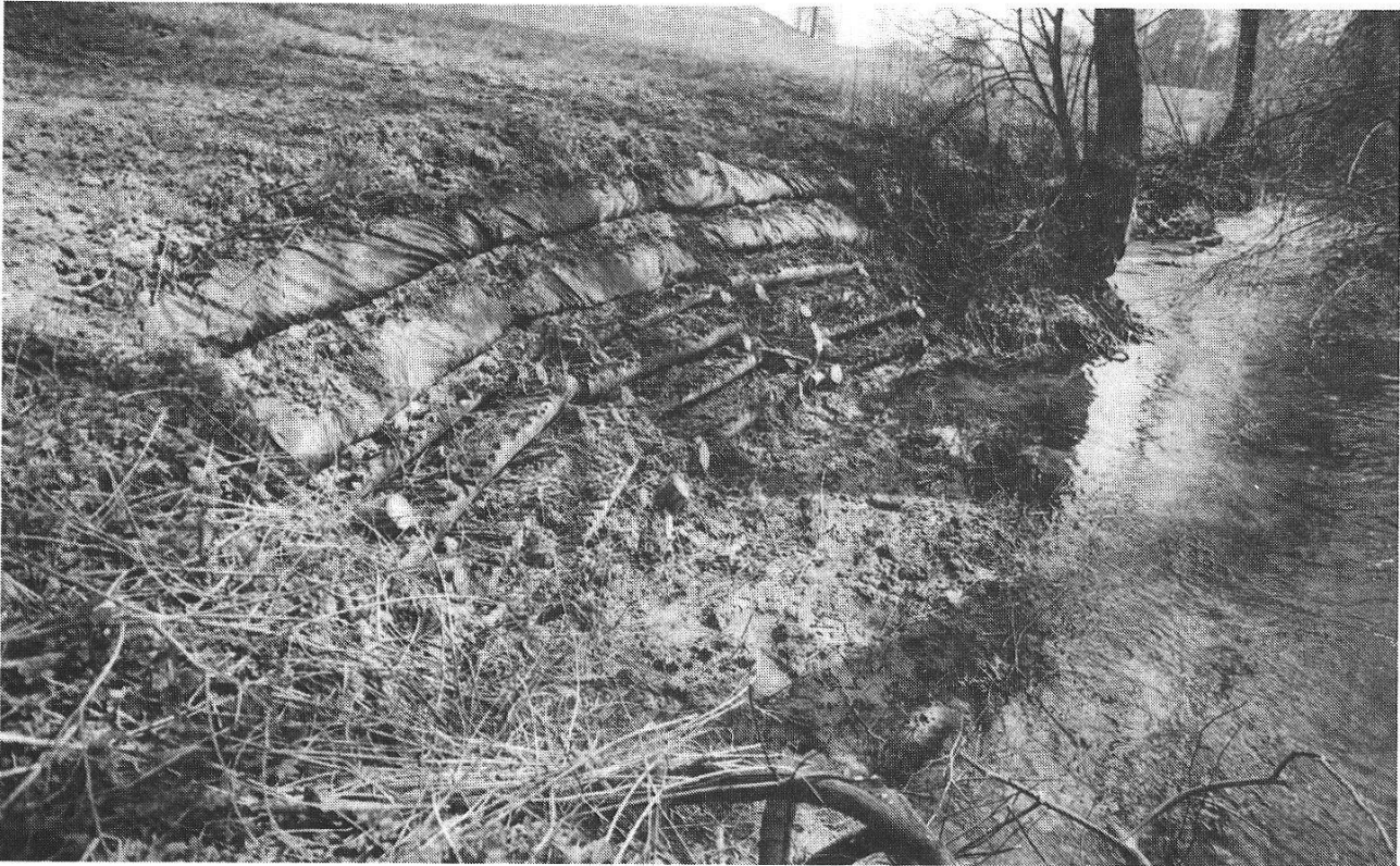
Abbildung 9: Beispiel 3: Mit Holzgrüenschwellen, Geotextilwalzen und Buschlagen befestigter Kolk. (Foto M. Cloetta)
