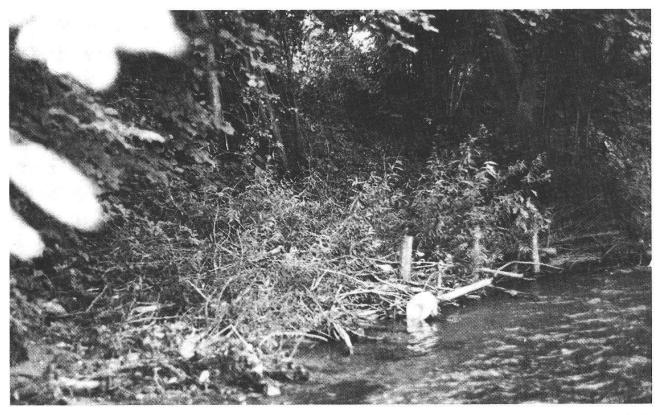
Abbildung 4: Beispiel 1: Drei Monate später ist der Gitterbuschbau verwachsen und zu <sup>2</sup>/<sub>3</sub> aufgefüllt. (Foto H. Zeh)
