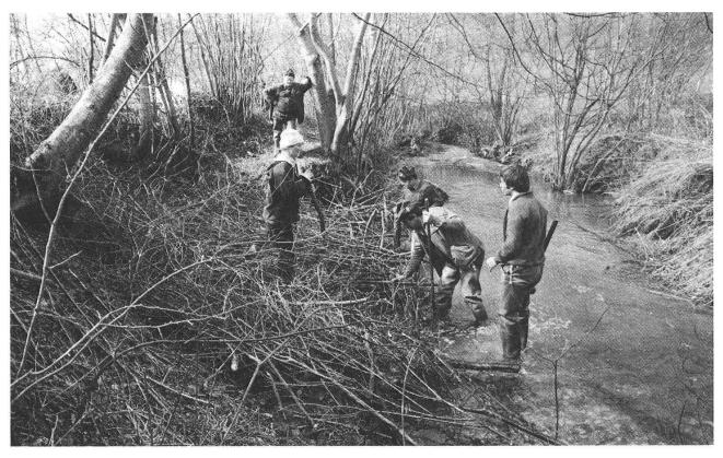
Abbildung 3: Beispiel 1: die Kursteilnehmer erstellen einen Gitterbuschbau, der den ganzen Kolk ausfüllt. (Foto M. Cloetta)
