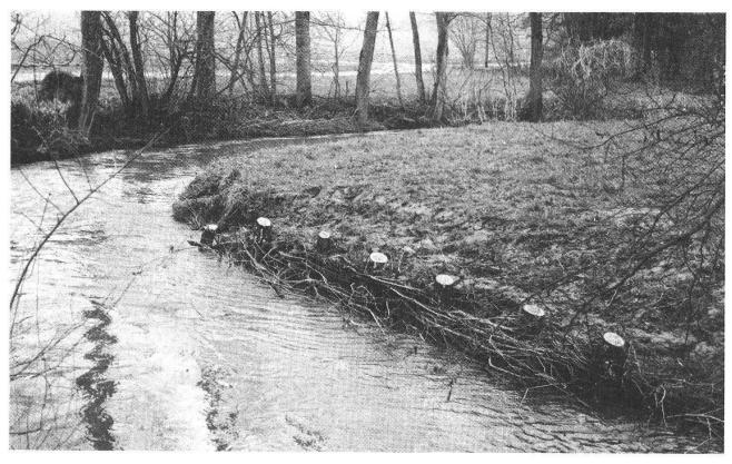
Abbildung 6: Beispiel 2: Flussabwärts aufgenommen: Eichenpfähle mit Astwerk verflochten, dahinter mit Kies gefüllte Geotextilsäcke, Grasnarbe darüber abgekantet. (Foto M. Cloetta)
