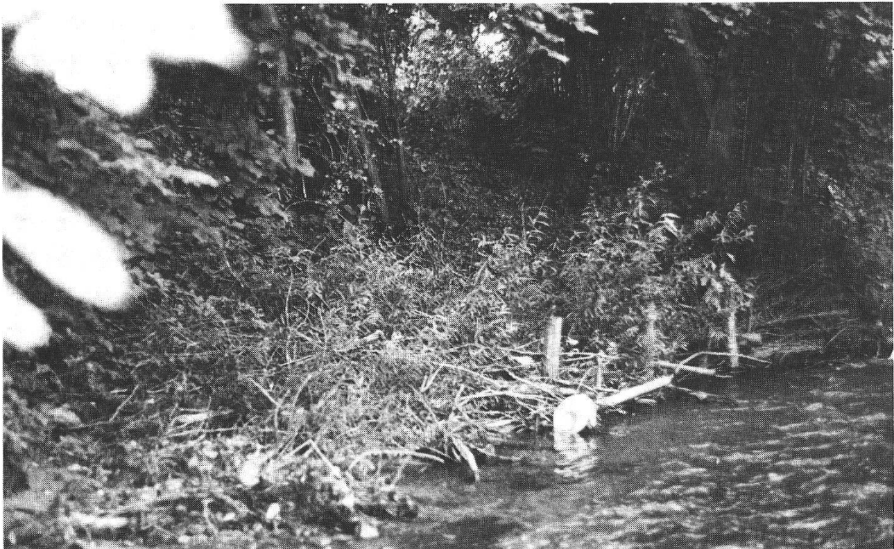
Abbildung 4: Beispiel 1: Drei Monate später ist der Gitterbuschbau verwachsen und zu \frac{2}{3} aufgefüllt. (Foto H. Zeh)
