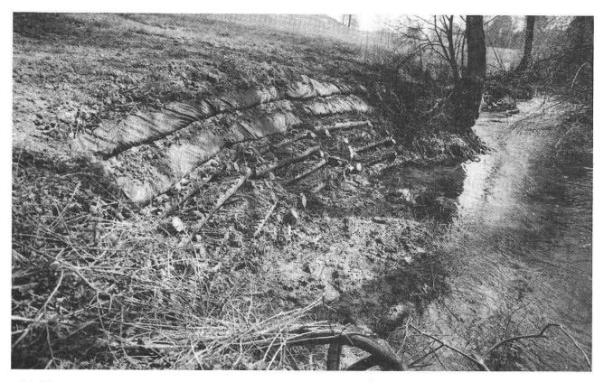
Abbildung 9: Beispiel 3: Mit Holzgrünschwellen, Geotextilwalzen und Buschlagen befestigter Kolk. (Foto M. Cloetta)
