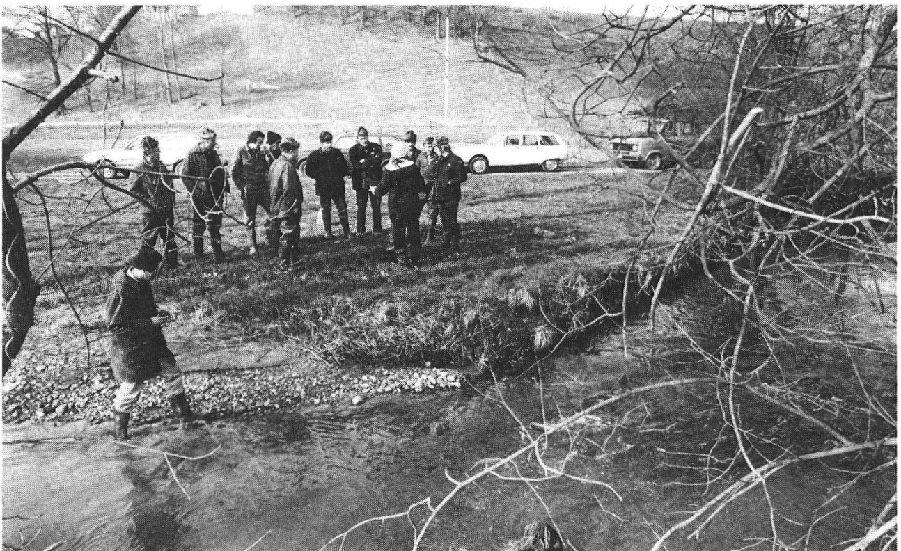
Abbildung 5: Beispiel 2: Flussaufwärts ist das linke Wiesenufer unterwaschen. Die Kursteilnehmer diskutieren: Wie kann man ein Wiesenufer stabilisieren, ohne Gehölze zu verwenden? (Foto M. Cloetta)
