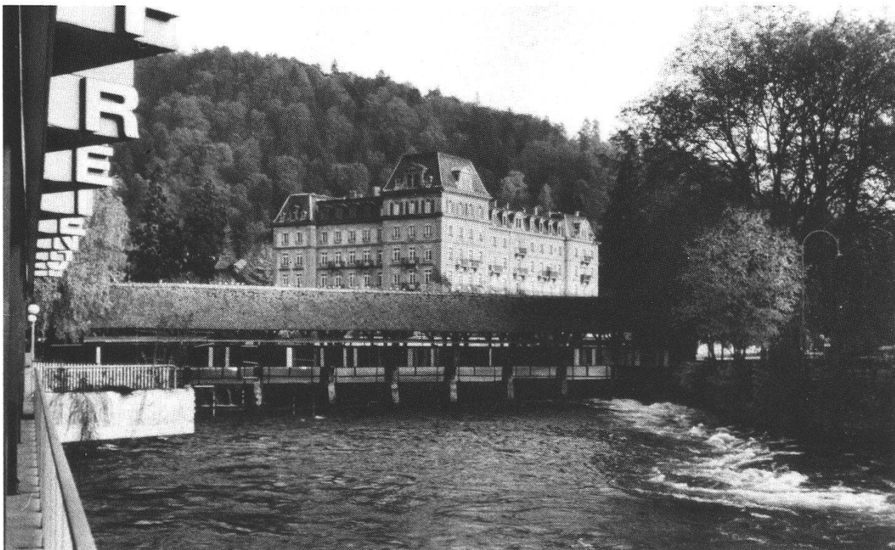
Abb. 1: Regulierwehr (Staatsschleusen) in Thun am Ausfluss des Thunersees.
