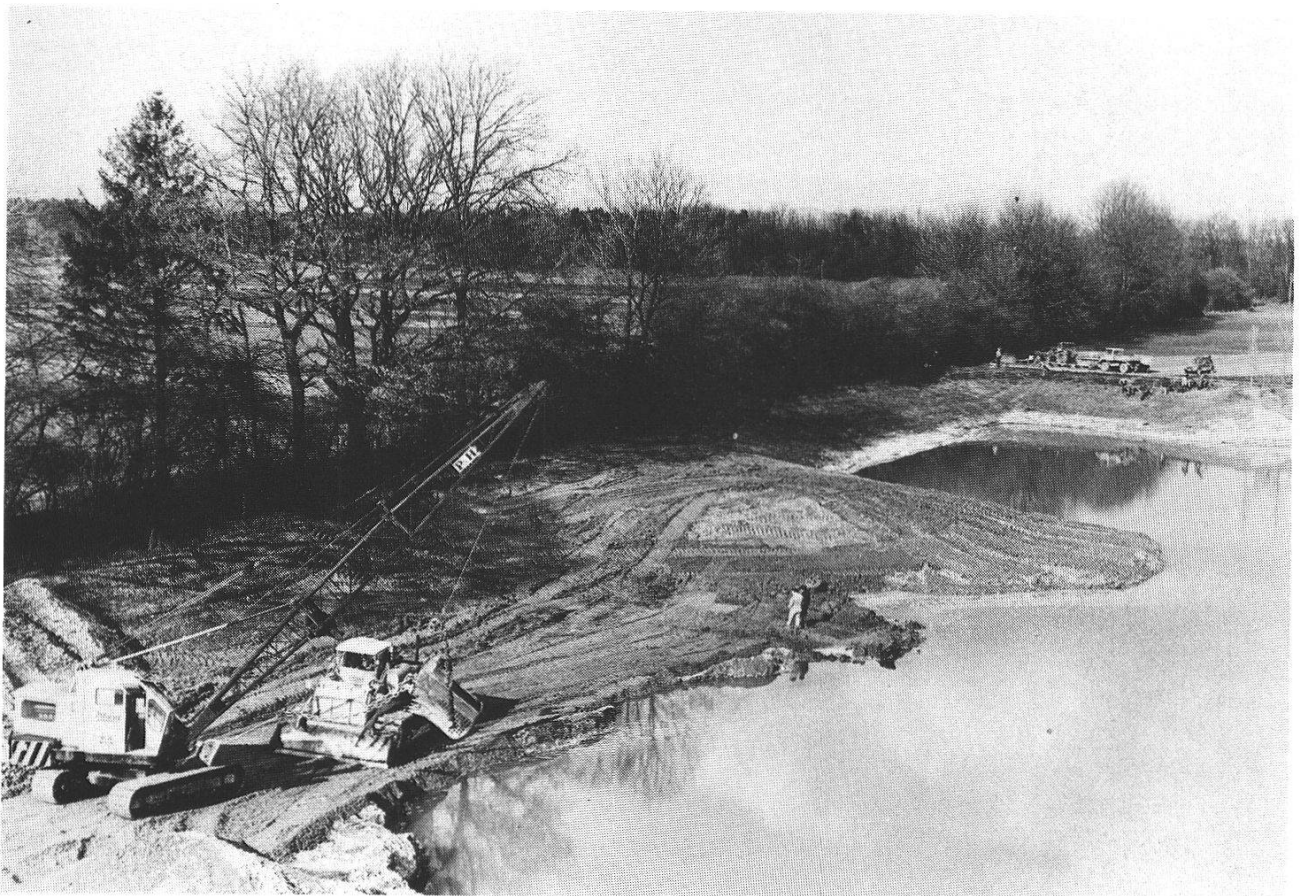
Abb. 4: Im Rahmen der Neugestaltung des kantonalen Naturschutzgebietes Büeltigen-Weiher, Gemeinde Kallnach, wird die Wasserfläche beinahe verdoppelt. Es entstehen verschiedene Lebensräume wie Schotterflächen, Verlandungszonen, Trockenstandorte und auch neue Hecken. Diese wurden unter Anleitung der Wegkommission von Kallnacher Schülern gepflanzt.
