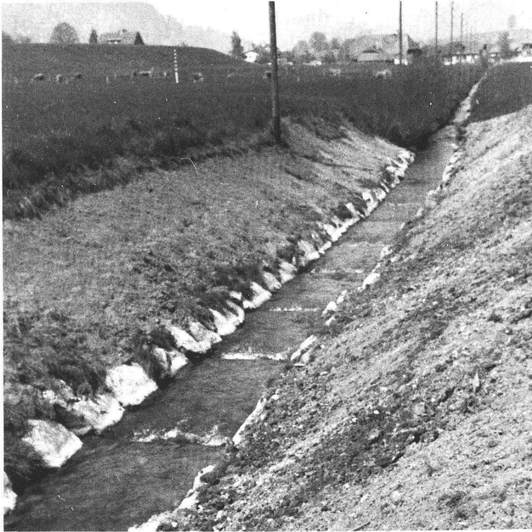
Abbildung 2: Schüpbach-Kanal; Neue und naturschützerisch bessere Verbauung eines bereits früher korrigierten und begradigten Gewässers: natürliche Sohle mit Schwellenhölzern, Ufersicherung mit Steinblöcken. Aus natur- und landschaftsschützerischer Sicht zu bemängeln ist vor allem das Fehlen einer geeigneten Neubepflanzung. Bei diesem Beispiel ist diese im Bachprofil aus wasserbaupolizeilichen Gründen nur bedingt möglich und infolge Nichtausscheidung des nötigen Landstreifens leider kaum mehr realisierbar.
