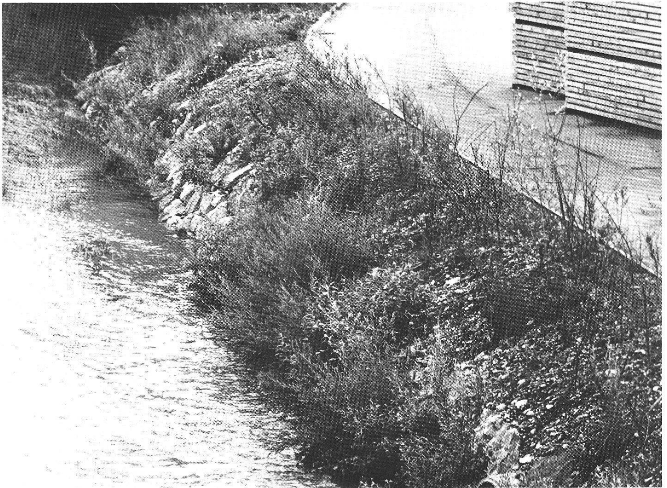
Abbildung 3: Emme-Ufer; mit Blockwurf und Lebendverbau (Weidenstecklingen) gesichertes Ufer. Wie das Bild zeigt, ist diese Verbauungsart bei günstigen Böschungsverhältnissen auch auf kleinem Raum anwendbar.
