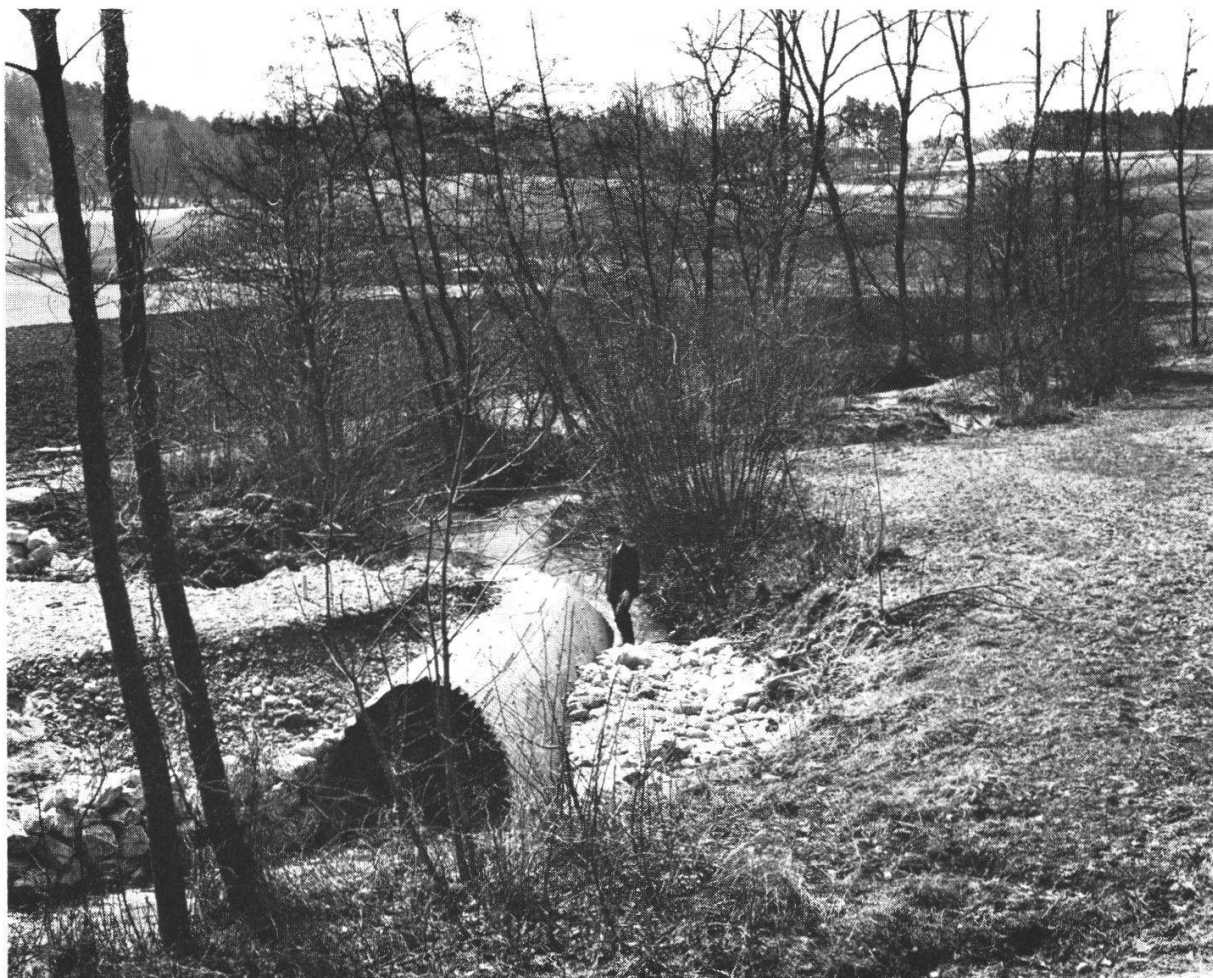
Abb. 2 Hier hat der Lyßbach im Januar/Februar 1970 gezeigt, welche Kraft er besitzt. Kurz zuvor war ein Durchlaß aus Wellstahlrohr erstellt worden, um die Zufahrt zum Kulturland ohne Benützung des gefährlichen Bahnübergangs zu ermöglichen. Der Einlauf war mit Natursteinen gesichert und das Rohr mit Kies und Erde überdeckt worden — in der guten Absicht, das Naturschutzgebiet möglichst wenig zu beeinträchtigen. Aber der Durchlaß erwies sich für das extreme Hochwasser als zu klein, und der Lyßbach hat sich am Rohr vorbei den Durchfluß erzwungen und dieses freigelegt. Was künstlich geschaffen worden ist, hat hier die Probe nicht bestanden. Um so mehr ist zu beachten, daß die natürliche Uferbestockung auch diesem Hochwasser gewachsen war! Nun muß ein Betonbrücklein erstellt werden. (Aufnahme A. Schmalz, 21. März 1970)
