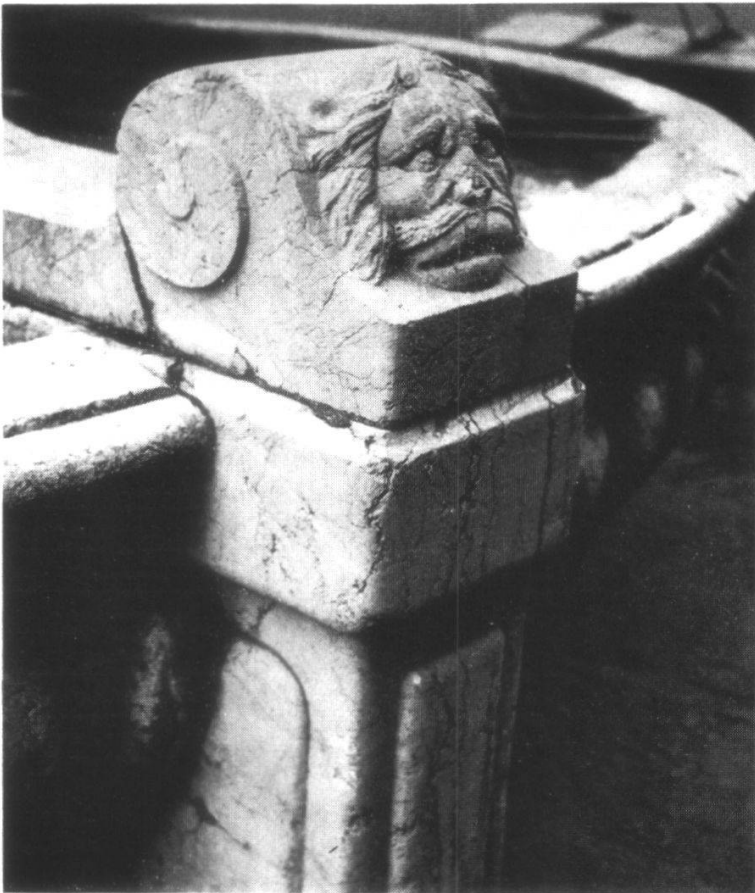
Abb. 8 Kreuzgaßbrunnen (Erneuerung von 1778). Pfeiler und Plastik aus alpinem Kalkstein (vielleicht Malmkalk von Zweilütschinen). Becken aus Solothurner Nerineenkalk.
