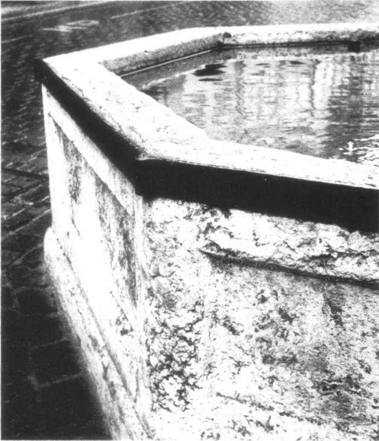
Abb. 7 Becken des Gerechtigkeitsbrunnens in der originalen Form von 1543. Einige der Platten vielleicht noch ursprünglich (alpiner Kalkstein), die andern in Solothurner Stein erneuert.
