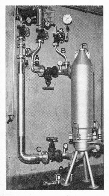
Abbildung 3 Wiegand-Maischeerwärmer mit den Dampf- und Heißwasserzuleitungen.
