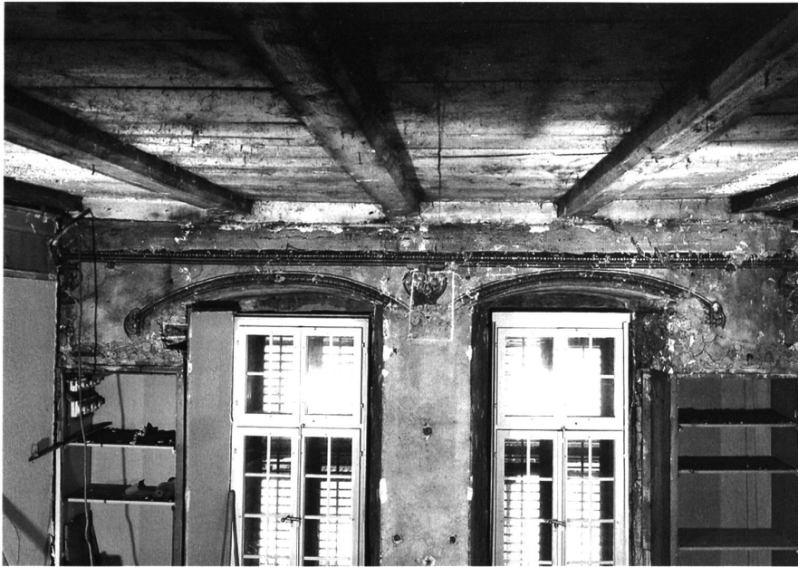
6: Thun, Schloss. Mittlerer Abschnitt des südlichen Schlosstrakts, kleiner Saal im ersten Obergeschoss des Kernbaus. Die Decke dürfte etwa zeitlich parallel zum Dachstuhl um 1566/67 entstanden sein. Die spätbarocke Grisaille-Malerei von 1700 an der Südwand deutet die ehemalige Fenstergliederung an. Blick nach Südwesten.
