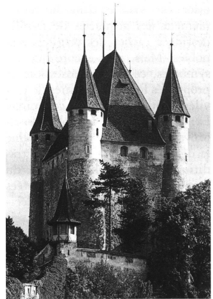
12: Thun, Schloss, bausteinerne, unten runde, im obersten Geschoss polygonale Türmchenaufsätze und Walmdach anstelle einfacherer Abschlüsse, um 1430/36 durch den Stand Bern erbaut.
