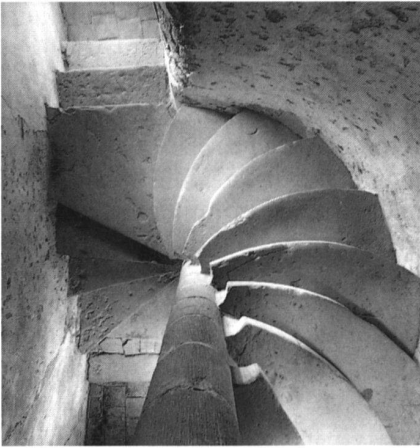
8: Worb, Schloss, konvexe Stufenbildung der Wendeltreppe von 1472.
