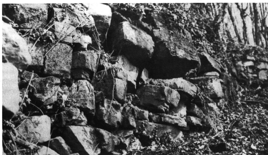
21: Castrum von Nimis (Friaul, Italien). Ostmauer der Festung bei Monte Nongruelle. Die massive, trocken geschichtete Mauer ist bis zu 4 m hoch erhalten.
