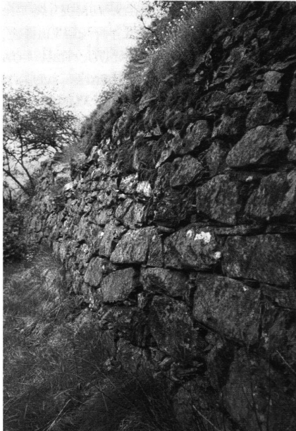
18: Wohl moderne Terrassenmauer 350 m nordwestlich des Caslasc.
