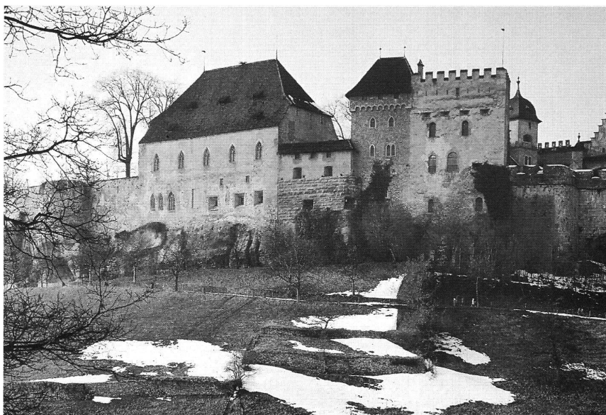
2: Lenzburg AG. Links der um 1300 errichtete Saalbau.
