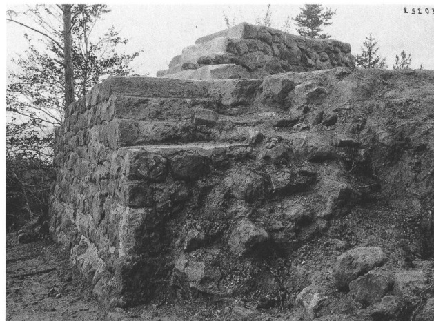
8, 9: 1926 freigelegte Mauerzüge auf dem obersten Plateau (M14, M9, M2, M3). Oberflächlich noch nicht freigelegte Mauern wurden bereits neu ausgefugt; frisch ausgefugtes Schalenmauerwerk stösst rechtwinklig an offenbar nicht erkanntes Kernmauerwerk und wird von diesem überlagert.
