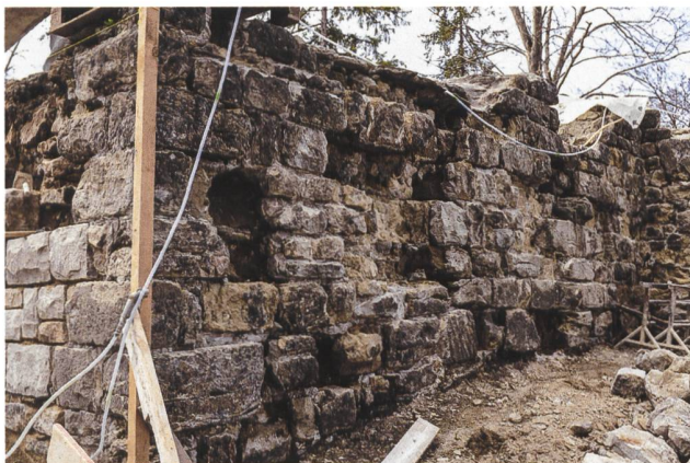
28: Mauer M1 nach dem Abspitzen der Fehlstellen.
