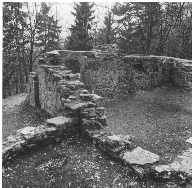
22, 23: Die südwestliche Ecke des Turms (M1/M2) mit ausgebrochenem Mauerfuss 1978; die Mauern auf dem Plateau (M8, M9) mit freiliegenden Mauerkronen und Fehlstellen 1980.
