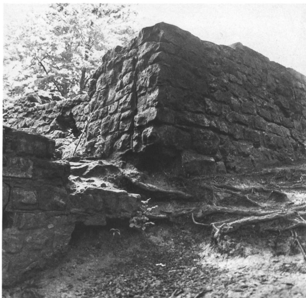
22, 23: Die südwestliche Ecke des Turms (M1/M2) mit ausgebrochenem Mauerfuss 1978; die Mauern auf dem Plateau (M8, M9) mit freiliegenden Mauerkronen und Fehlstellen 1980.
