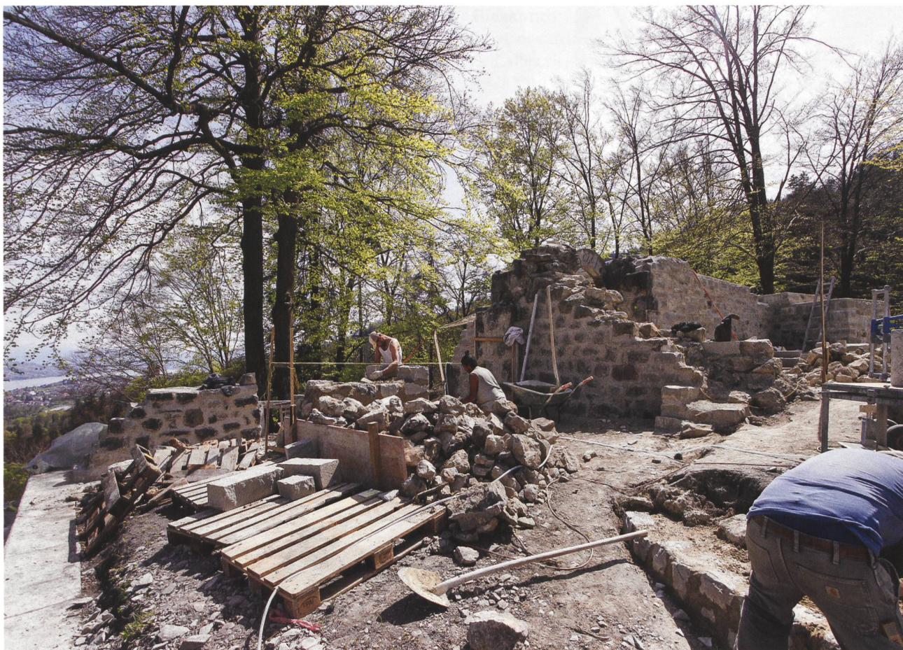
32: Sanierungsarbeiten im Sommer 2021.
