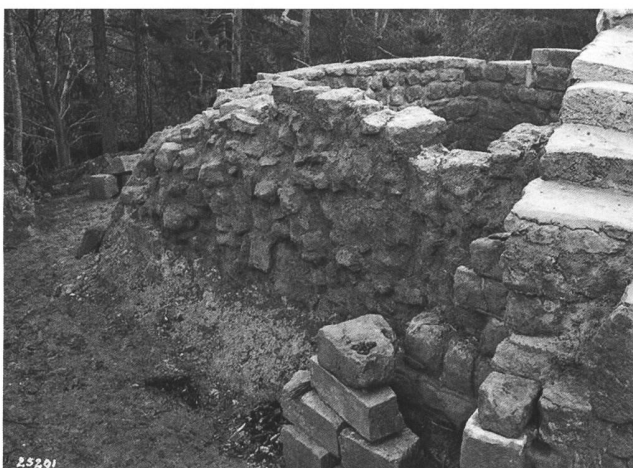
10, 11: Der 1925/26 freigelegte Turm mit offenbar in situ angetroffenem Mauerkerne der Ostmauer M1; Aufmauerung einer neuen Schale mit Steinen aus dem Aushub.
