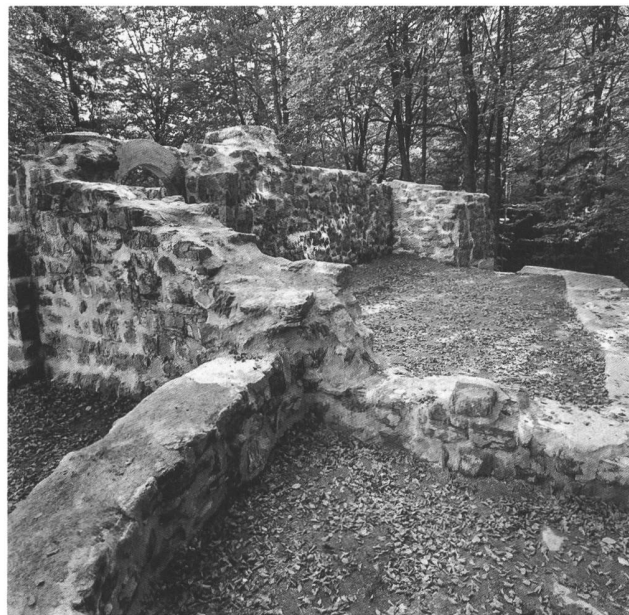
26, 27: Blick auf das Plateau mit neu ausgemörtelten Mauerfugen und ersetzttem Portalbogen aus Beton (M16, M14, M9); neue Mauerkronenabdeckungen aus Mörtel (M17, M9, M7, M6, M8), September 1995.
