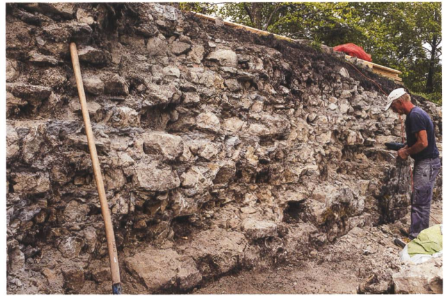
29: Umfangreiche Rückbauarbeiten an M13.
