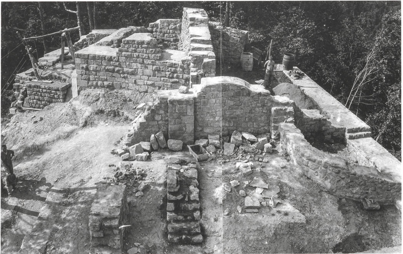
17: Übersicht September 1929, weitgehend neu errichtete Mauern auf dem Plateau. Links oben die Seilbahn für den Materialtransport.
