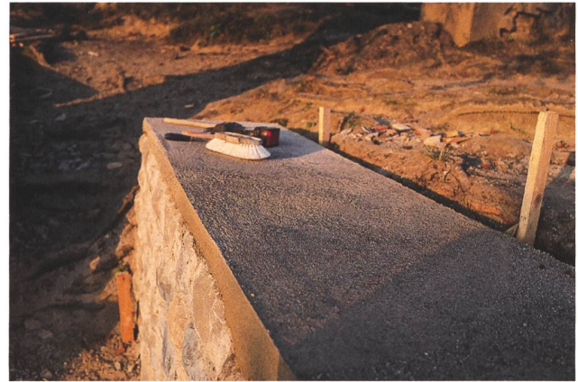
31: M16 nach dem Ausschalen der Mörtelabdeckung.
