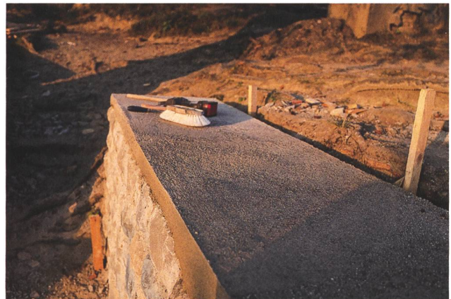
31: M16 nach dem Ausschalen der Mörtelabdeckung.
