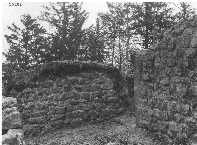
8, 9: 1926 freigelegte Mauerzüge auf dem obersten Plateau (M14, M9, M2, M3). Oberflächlich noch nicht freigelegte Mauern wurden bereits neu ausgefugt; frisch ausgefugtes Schalenmauerwerk stösst rechtwinklig an offenbar nicht erkanntes Kernmauerwerk und wird von diesem überlagert.
