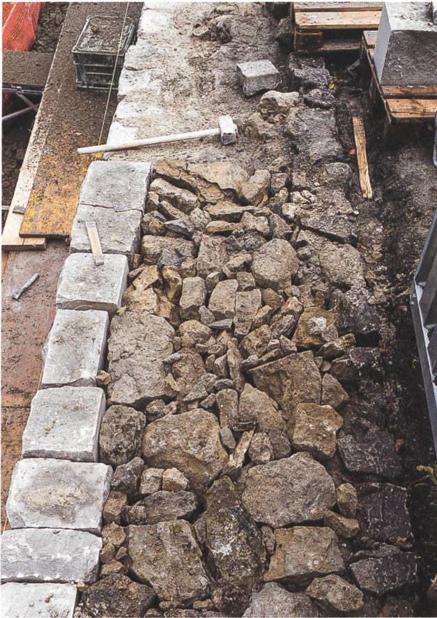
30: M7 vor dem Schalen für die Mörtelabdeckung.
