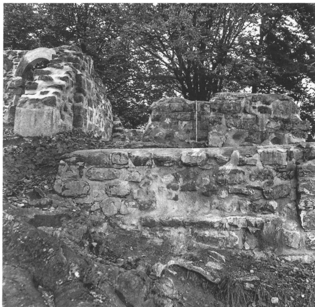
26, 27: Blick auf das Plateau mit neu ausgemörtelten Mauerfugen und ersetzttem Portalbogen aus Beton (M16, M14, M9); neue Mauerkronenabdeckungen aus Mörtel (M17, M9, M7, M6, M8), September 1995.
