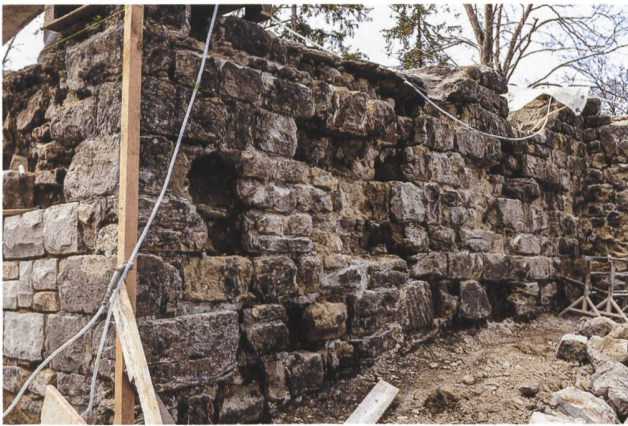
28: Mauer M1 nach dem Abspitzen der Fehlstellen.
