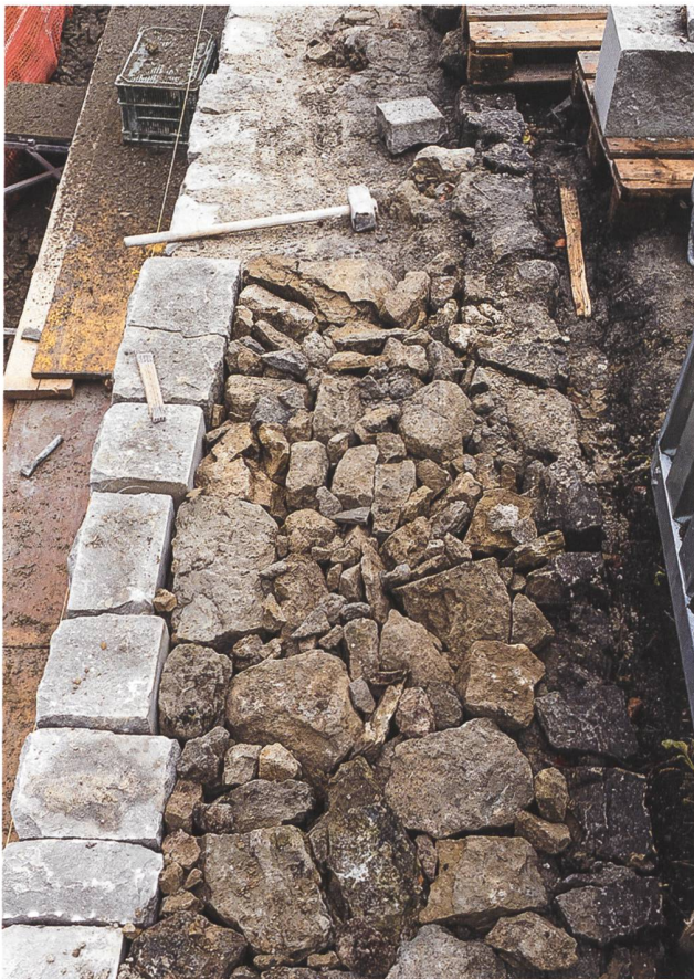
30: M7 vor dem Schalen für die Mörtelabdeckung.
