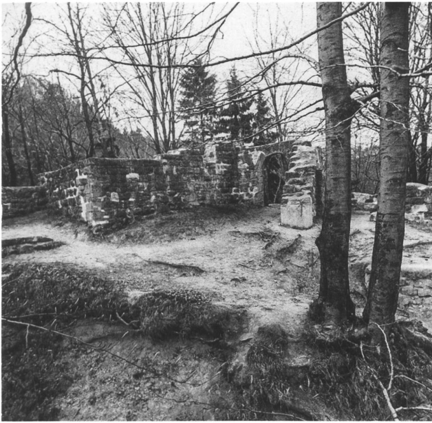
24, 25: Blick auf die Mauern M1, M2, M9 und M10 mit neu ausgemörtelten Fugen; Detail des Portals M10 aus originalen Werkstücken, März 1982.
