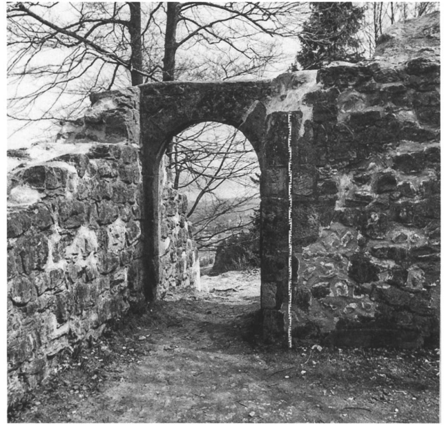
24, 25: Blick auf die Mauern M1, M2, M9 und M10 mit neu ausgemörtelten Fugen; Detail des Portals M10 aus originalen Werkstücken, März 1982.
