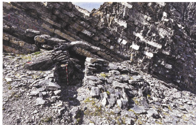
8: Alte Gemmi. Le bâtiment aménagé au col. Vue depuis l'est.
