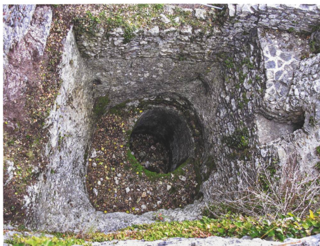
2: Château de Dorneck SO. Puits creusé à partir du fond de la fosse d'une citerne à filtration supposée.
