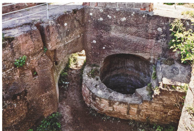
7: Château de Ramburg (Palatinat, D). Puits creusé à partir du fond de la fosse d'une ancienne citerne à filtration transformée en salle souterraine (?).
