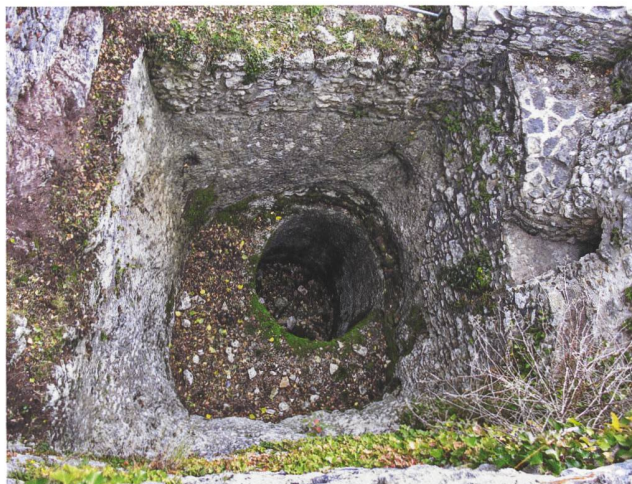
2: Château de Dorneck SO. Puits creusé à partir du fond de la fosse d'une citerne à filtration supposée.
